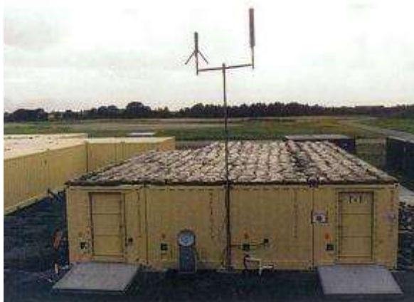
Figura 18: Abrigo formado por várias unidades MSS.
