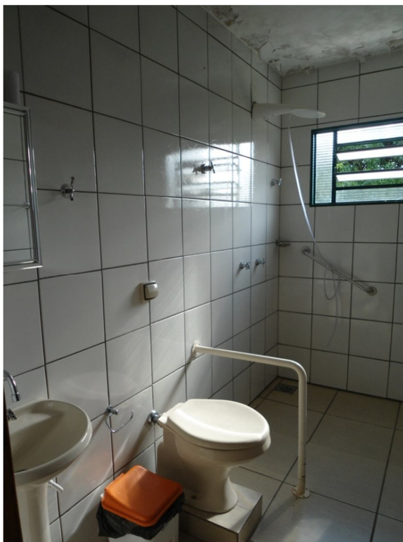
Figura 36 - Banheiro do apartamento, provido de barras de apoio Fonte: Elaborada pela autora
