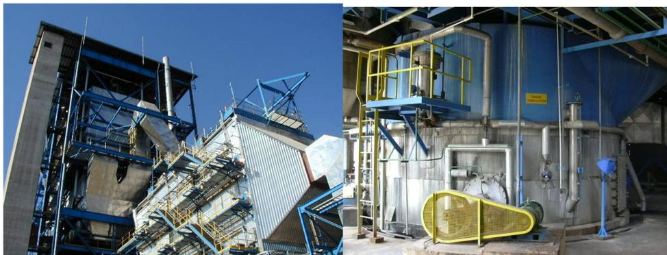
Figura 8 – Vista geral da caldeira de recuperação e tanque dissolvedor
