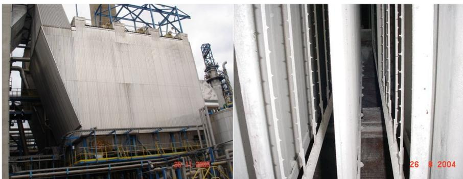
Figura 9 – Vista geral e interna do precipitador eletrostático
