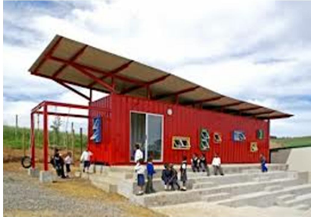
Figura 11 - Sala de aula feita em container.
