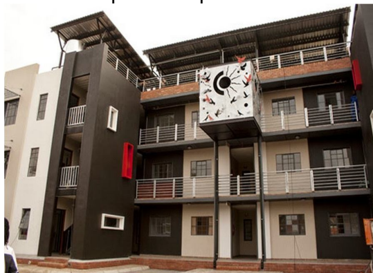
Figura 6 – Utilização de containers na construção de quitinetes para estudantes.
