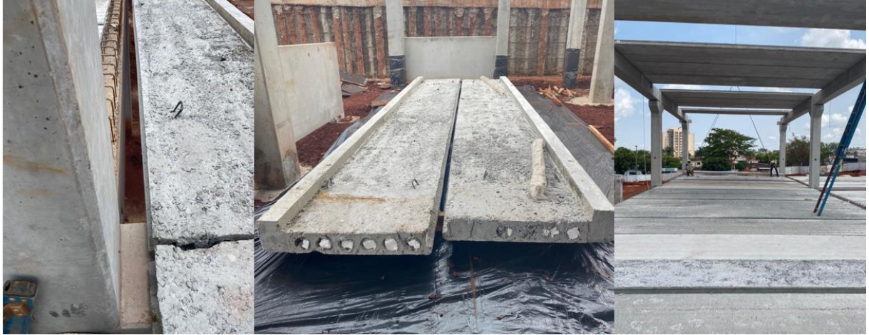
Figura 19 – Textura da face superior, aspecto rústico que dará aderência no capeamento
