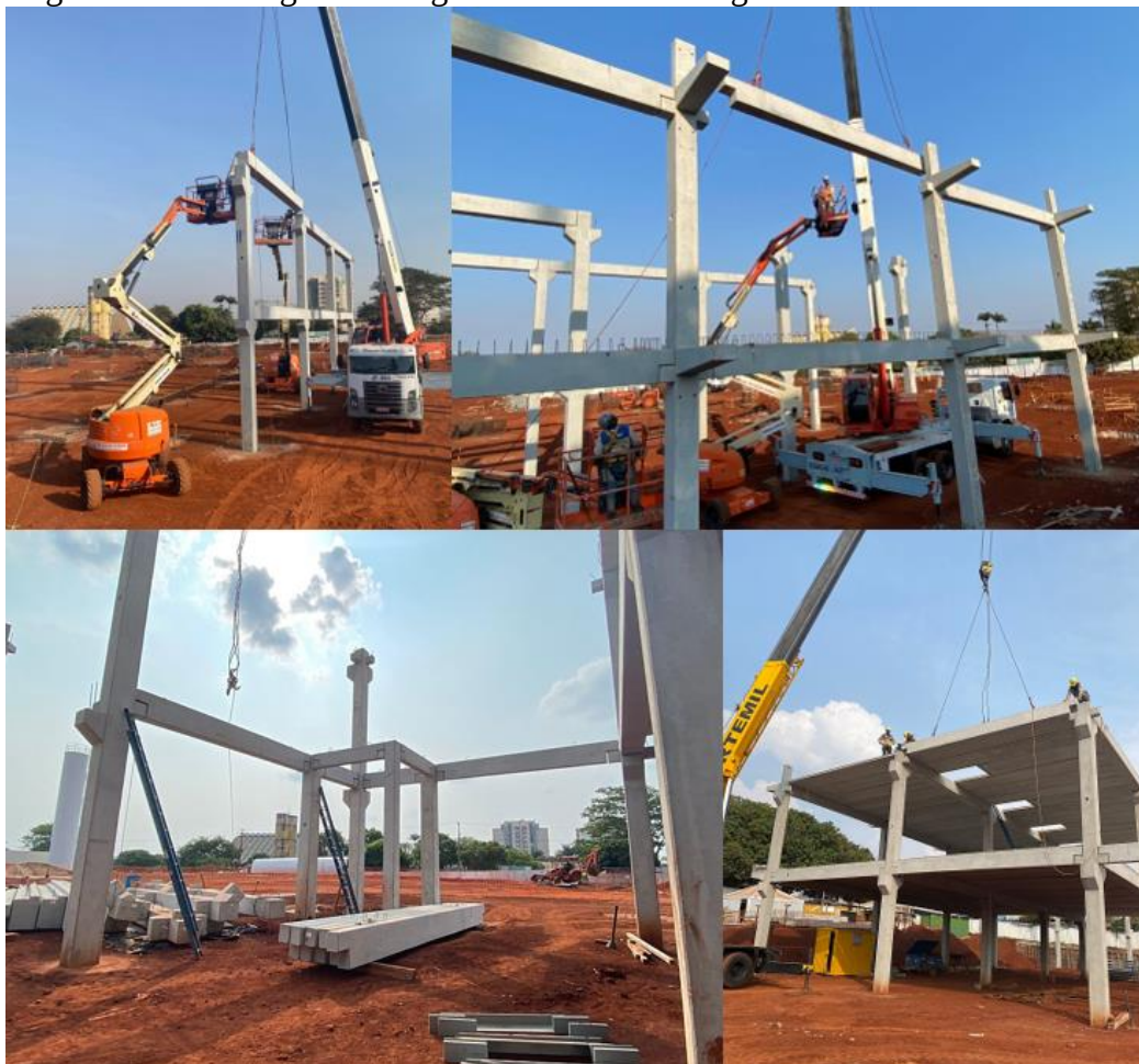
Figura 17 – Montagem das vigas com o auxílio de guindaste e PTAs
