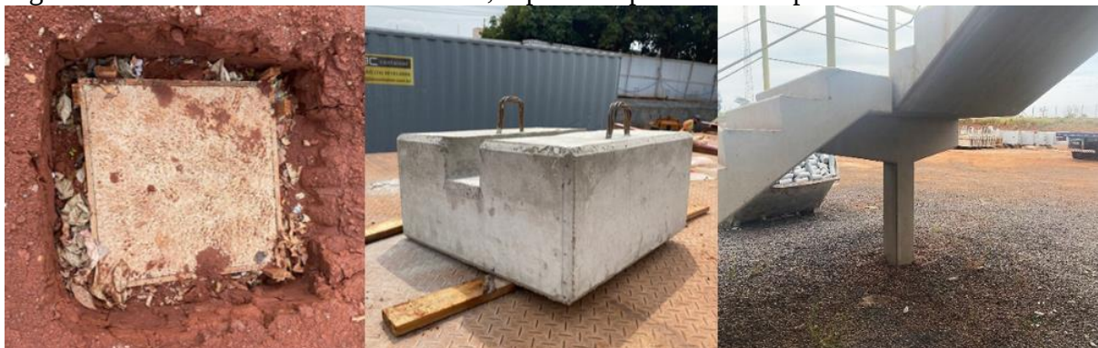
Figura 23 – Detalhe do lastro de concreto, sapata de apoio e escada pré-fabricada
