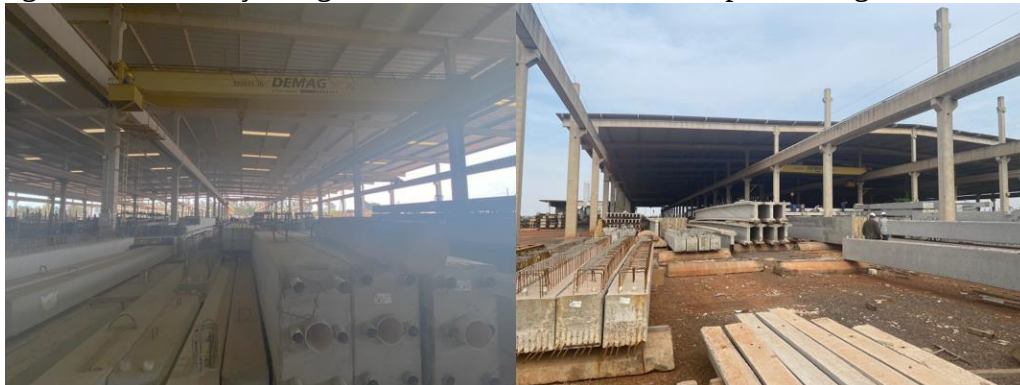
Figura 5 – Ponte rolante que movimenta as peças e as armazena no pátio aguardando liberação segundo alcance do FCK mínimo para entrega na obra
