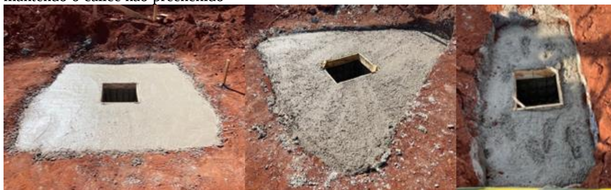
Figura 10 – Após travamento da armadura na posição correta é realizada a concretagem, mantendo o cálice não preenchido
