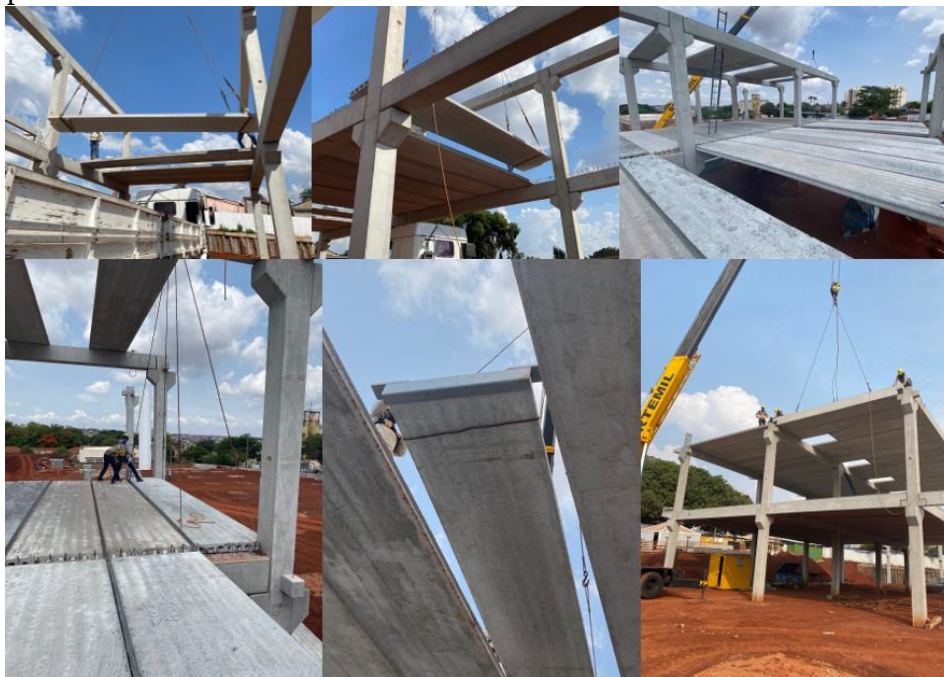
Figura 21 – Processo de montagem das lajes com auxílio do guindaste, peças apoiadas nas vigas ou suporte metálico no caso das aberturas no pavimento de cobertura
