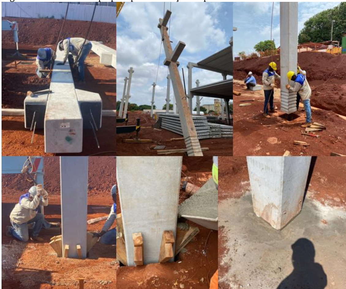
Figura 14 – Processo de preparo para instalação do pilar
