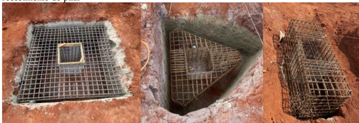
Figura 9 – Após chapisco das paredes os blocos de armadura são posicionados segundo marcação topográfica necessária para que o cálice fique no nível e eixo necessários para recebimento do pilar
