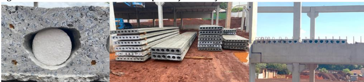
Figura 18 – Detalhe das cordoalhas de protensão nas lajes alveolares
