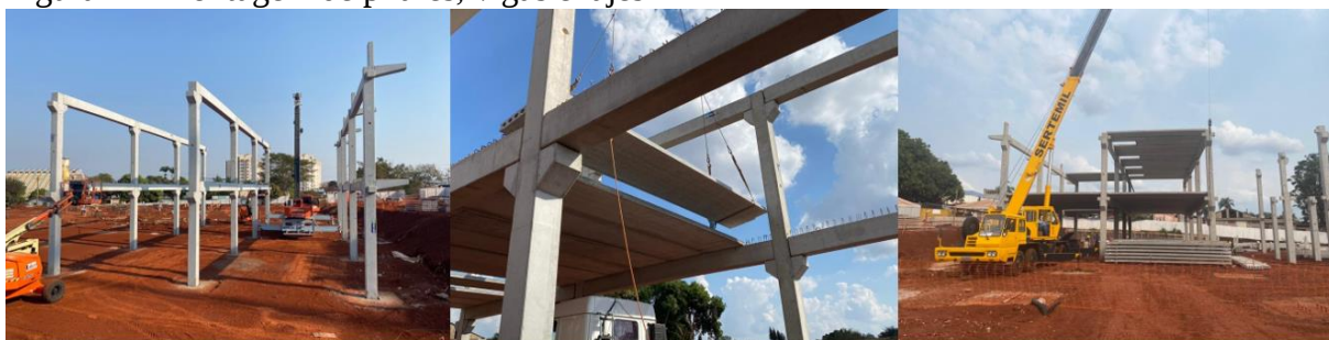
Figura 7 – Montagem de pilares, vigas e lajes
