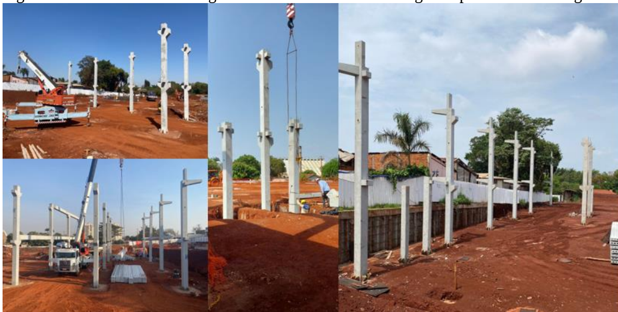
Figura 15 – Pilares instalados aguardando cura de 24 horas do graute para receber as vigas
