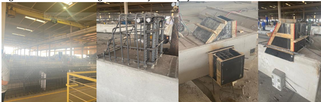
Figura 3 – Área de montagem de armação das peças forma e consolos
