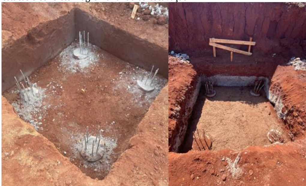
Figura 8 – Escavação dos blocos de fundação e arrasamento da cabeça das estacas e concreto magro no fundo da escavação
