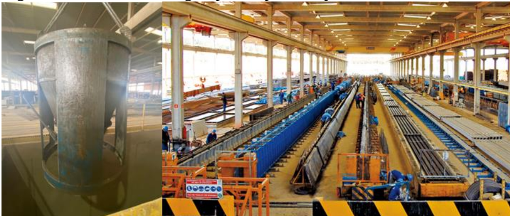
Figura 4 – Funil de concretagem para as pistas de protensão
