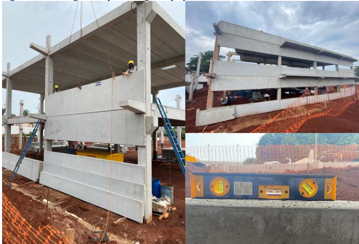
Figura 26 – Montagem dos painéis segundo projeto de fachada
