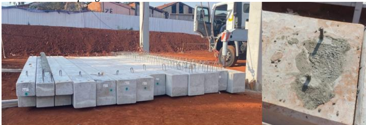
Figura 16 – Formato das vigas, alguns com armadura complementar para o piso e a viga já montada e os arranques grauteados
