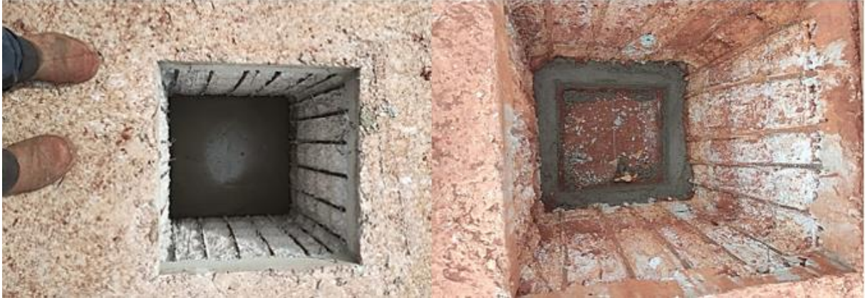
Figura 11 – O último passo para que o bloco de fundação esteja pronto, é regularizar o fundo do cálice e a concretagem de um ‘anel’ para servir de guia para o pé do pilar
