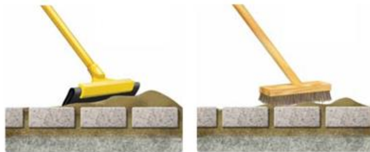
Figura 17 - rejuntamento das juntas dos blocos de concreto
