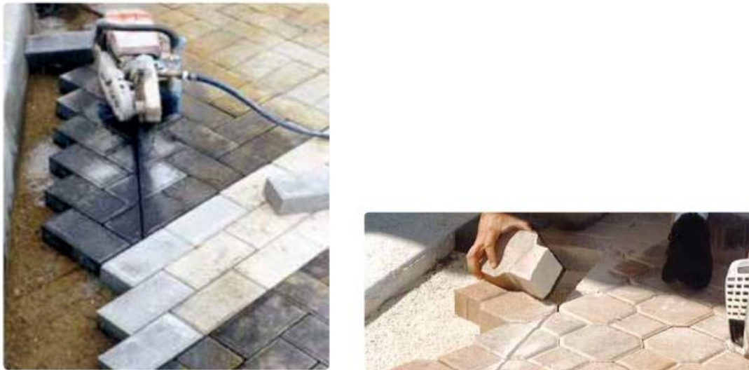
Figura 15 - Corte (tipo 2) para finalização da pavimentação intertravada
