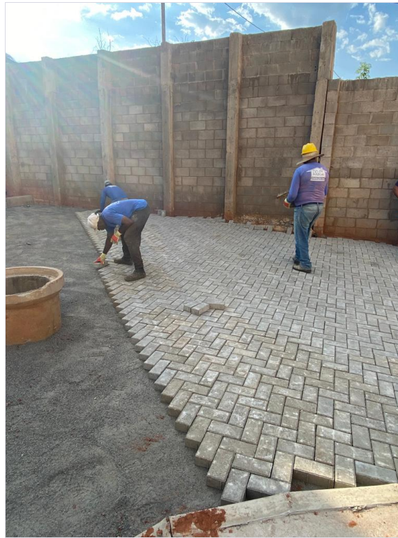
Figura 13 - Assentamento manual de blocos intertravados
