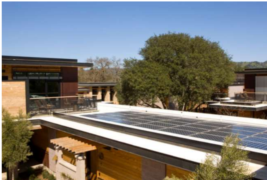
Figura 40 – Placas solares na cobertura da edificação
