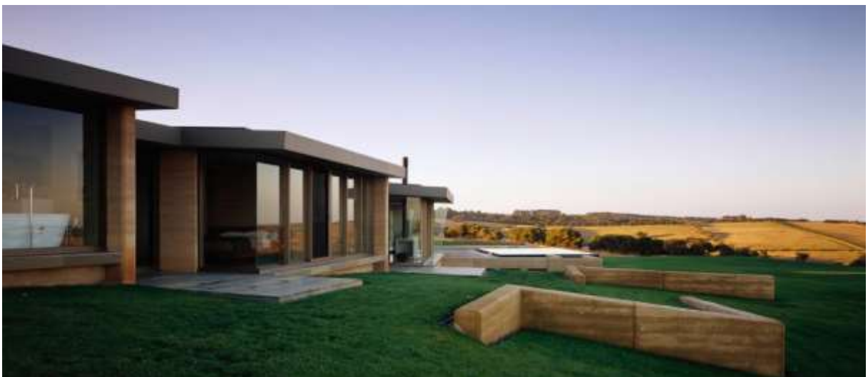
Figura 11 – Vista dos fundos com os módulos e deck
