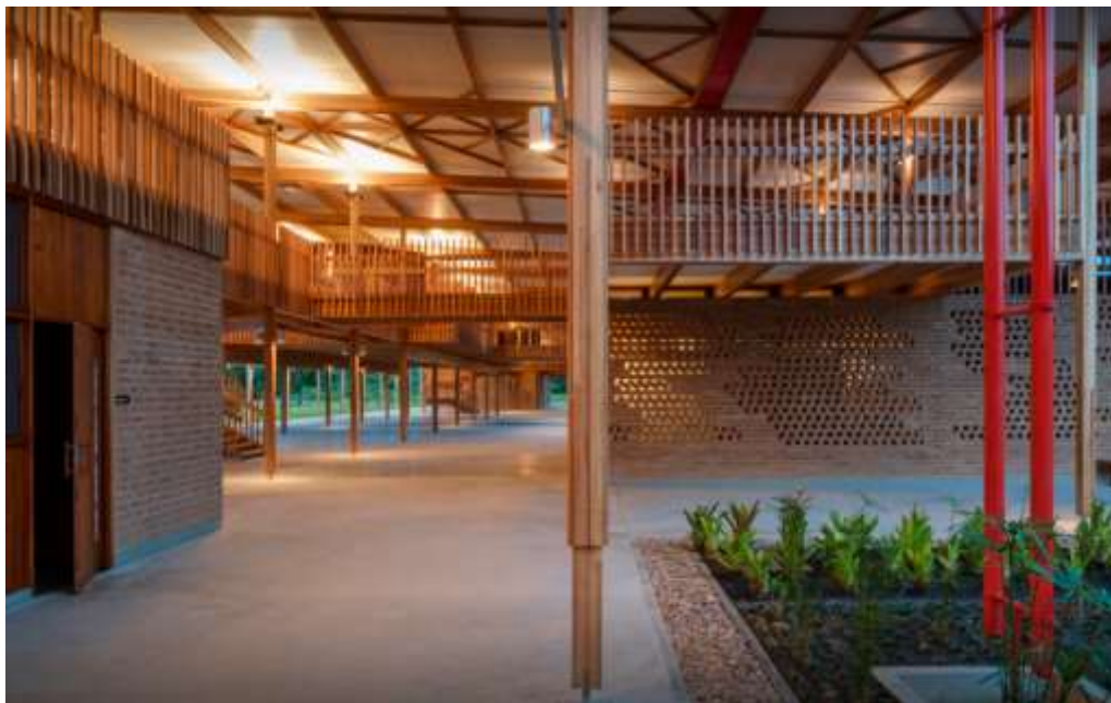
Figura 32 – Visão do interior da edificação
