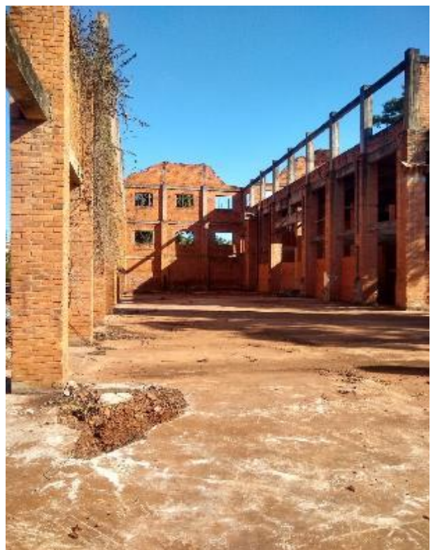
Figura 19. Vista interna do pátio.
