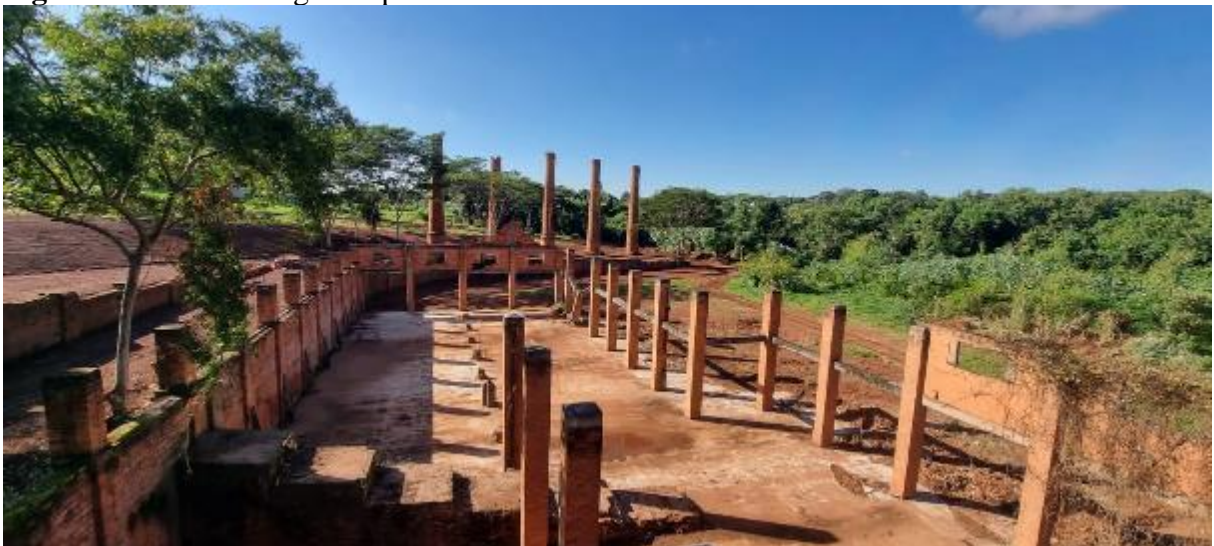
Figura 17. Vista do segundo pavimento do edifício.
