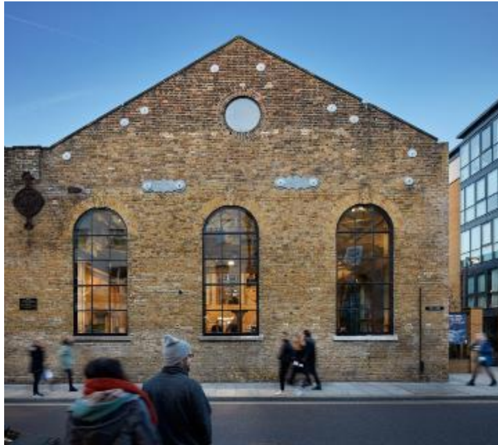
Figura 6. Fachada do edifício.
