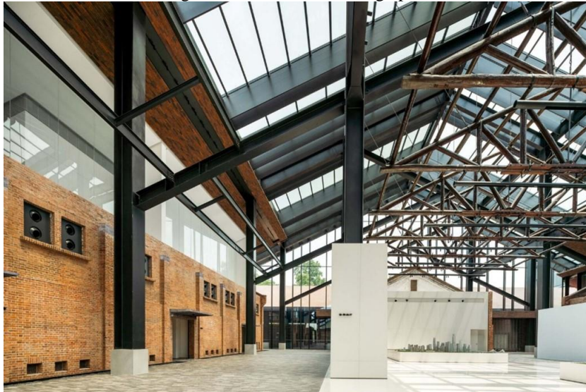
Figura 20 - Área interna do galpão.
