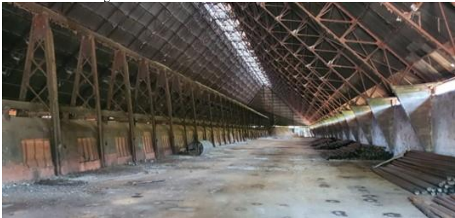
Figura 16 - Área interna de um dos silos da fábrica.
