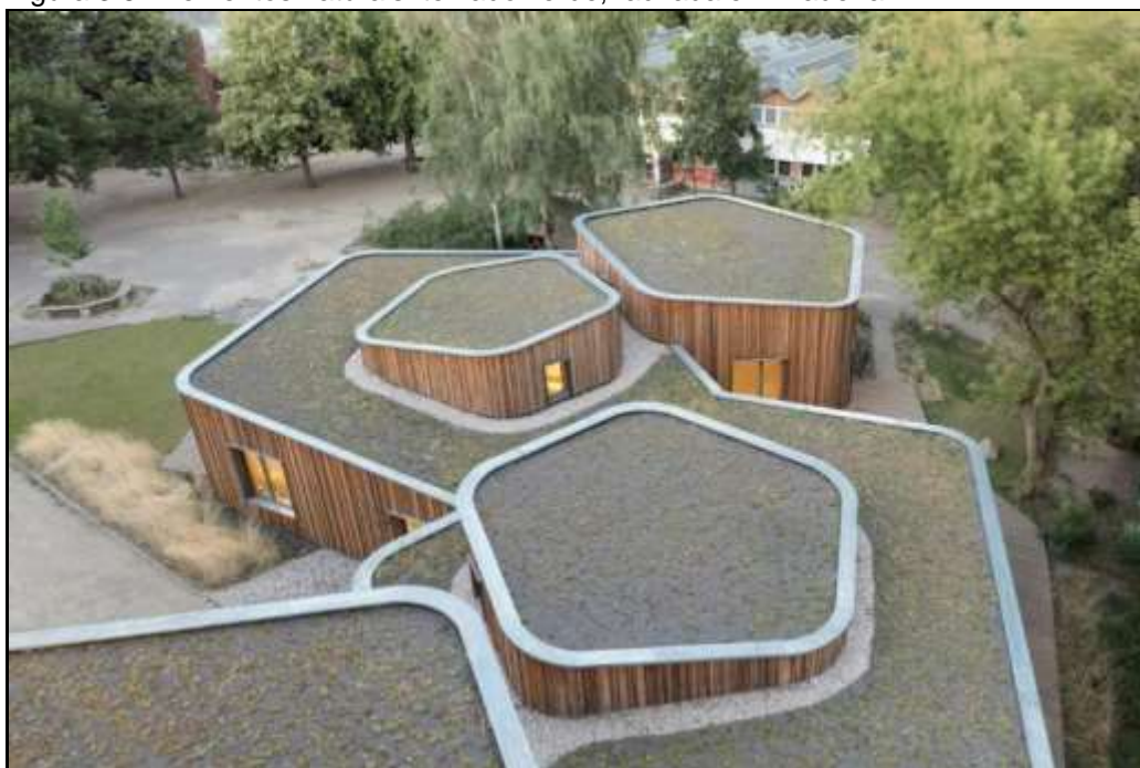
Figura 3.5: Elementos naturais: telhado verde, fachada em madeira
