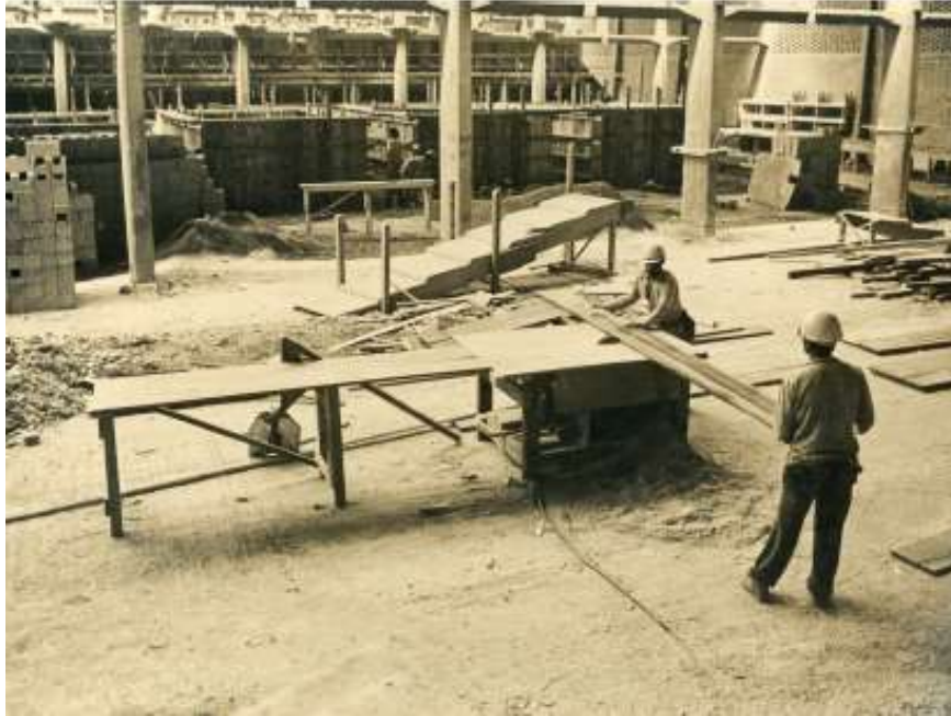
Figura 7 - Sesc Pompeia. Protótipo Em segundo plano, protótipo de escada – rampa de acesso para os vestiários.
