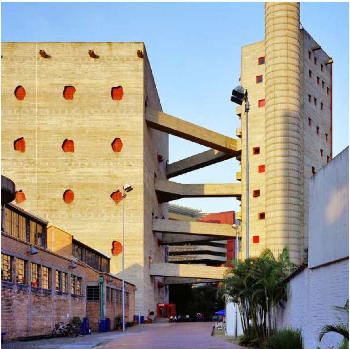
Figura 9 - Sesc Pompeia. Vista do prédio.
