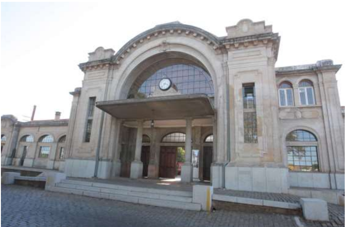
Figura 35 - Botucatu. Estação após ser restaurada.
