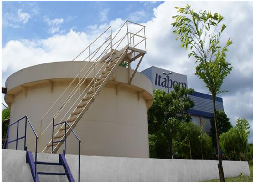
Ilustração 14: Flotador - separa a gordura da água
