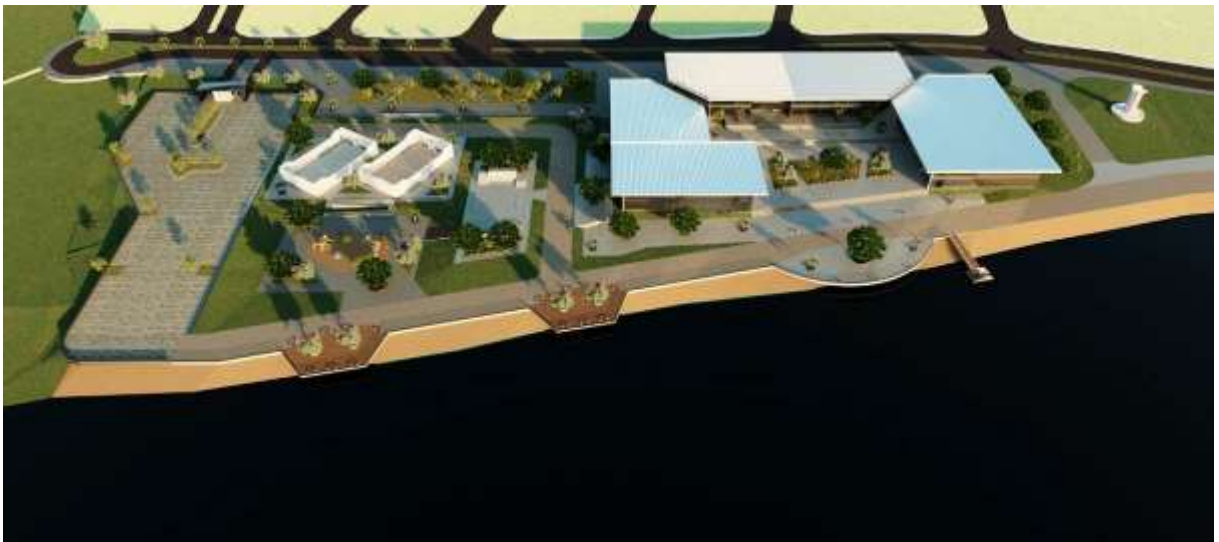
Figura 34 – Vista aérea 2 do projeto.
