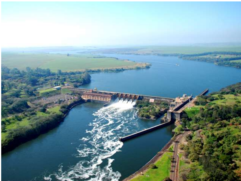
Figura 15 – Eclusa e Usina Hidrelétrica de Barra Bonita
