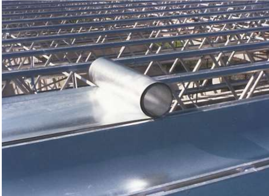
Figura 27 – Cobertura metálica Roll-on.
