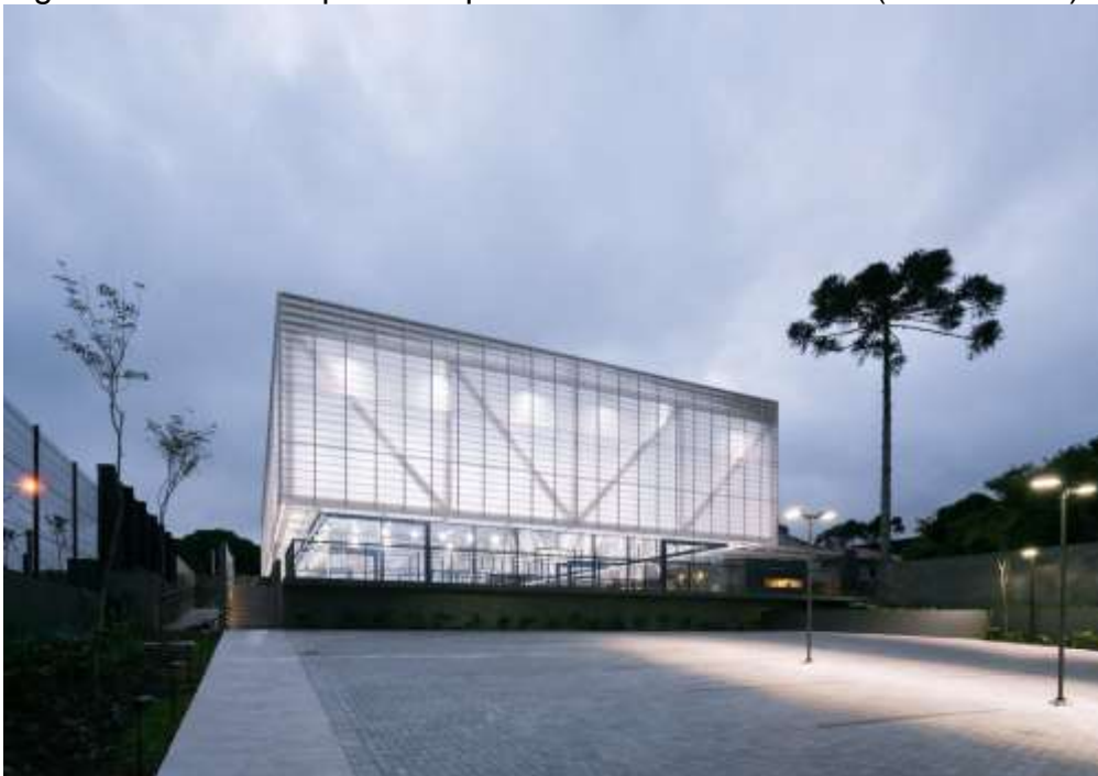
Figura 7 - Novo complexo de pádel do clube Curitibano (Curitiba-PR).
