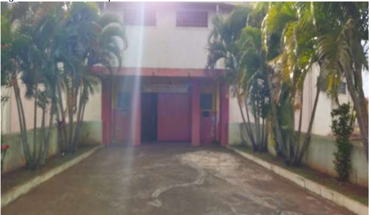
Figura 16 – Acesso Principal do Ginásio.
