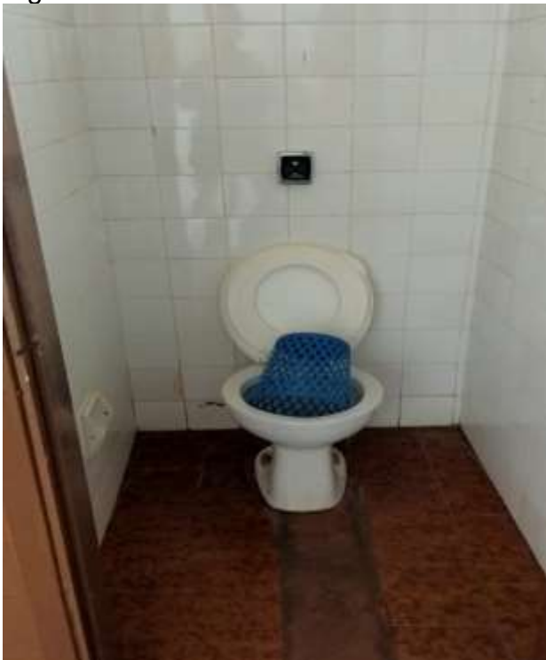
Figura 28 - Box banheiro masculino.
