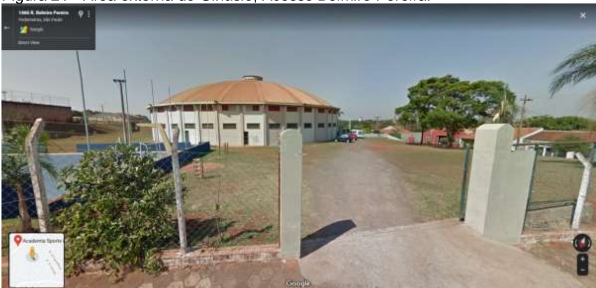
Figura 21 - Área externa do Ginásio, Acesso Belmiro Pereira.
