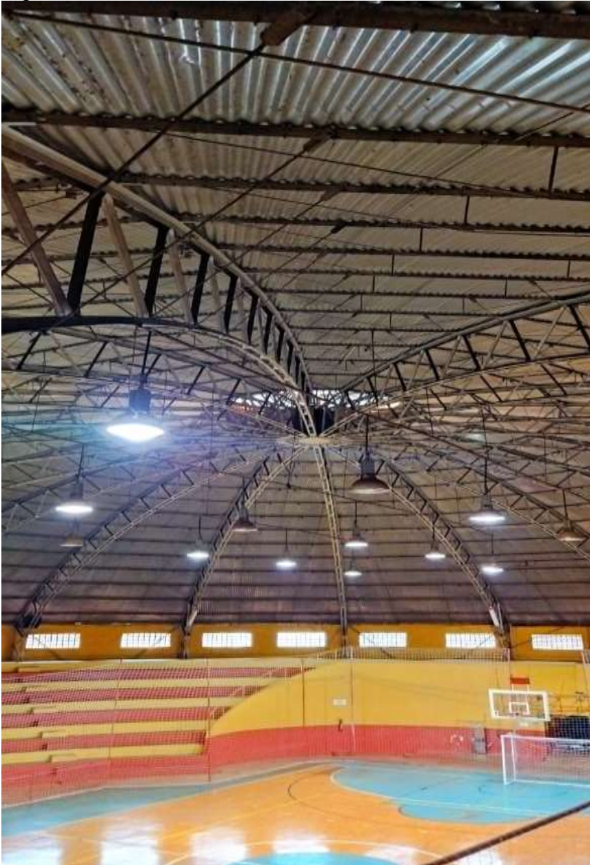
Figura 17 - Vista Interna - Estrutura Metálica.
