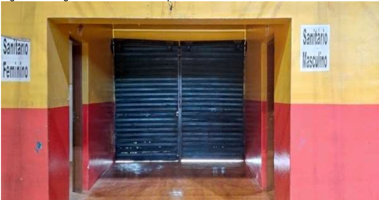
Figura 25 – Figura 25 - Acesso Principal dos Sanitários.
