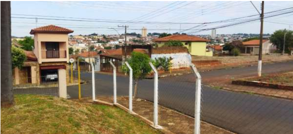
Figura 19 - Vista interna do cruzamento entre a Rua Felpe A Franco e Belmiro Pereira.
