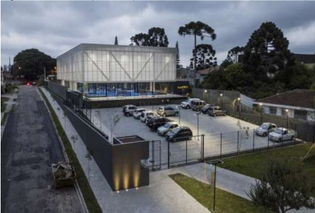
Figura 8 - Novo complexo de pádel do clube Curitibano (Curitiba-PR).
