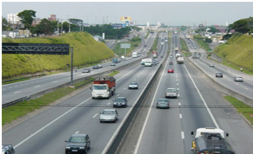
Figura 4: Rodovia Castelo Branco
