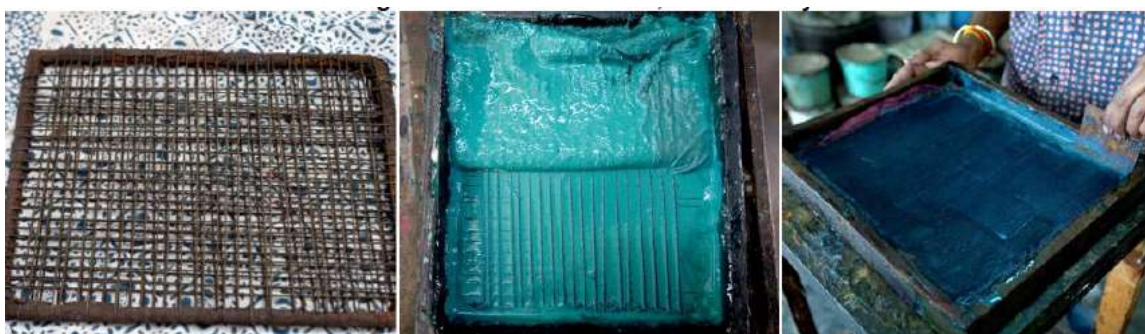
Figura 4 Combinação interna de uma malha de ferro
