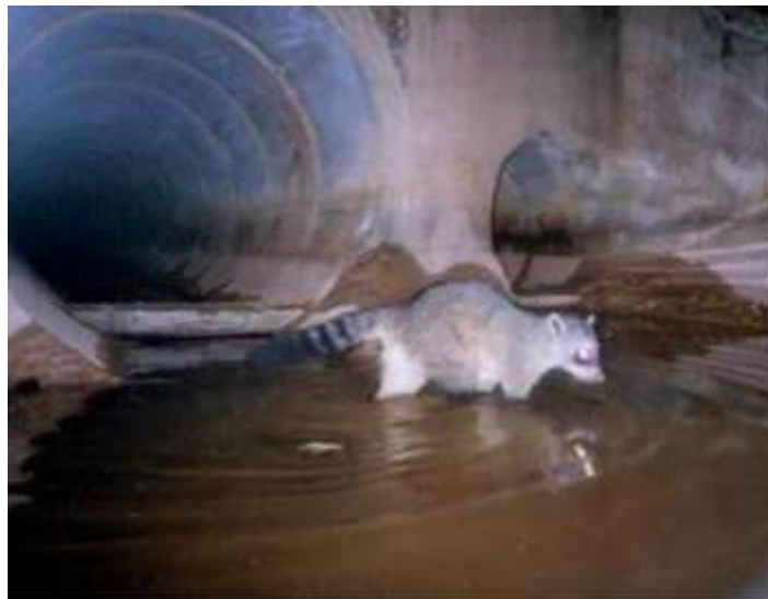
Figura 7 – Passagem de Fauna sob a Rodovia Do Sol ES-060, ES, Brasil
