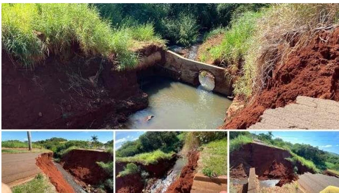
Figura 18- Situação atual da Av. João Paulo II em Barra Bonita
