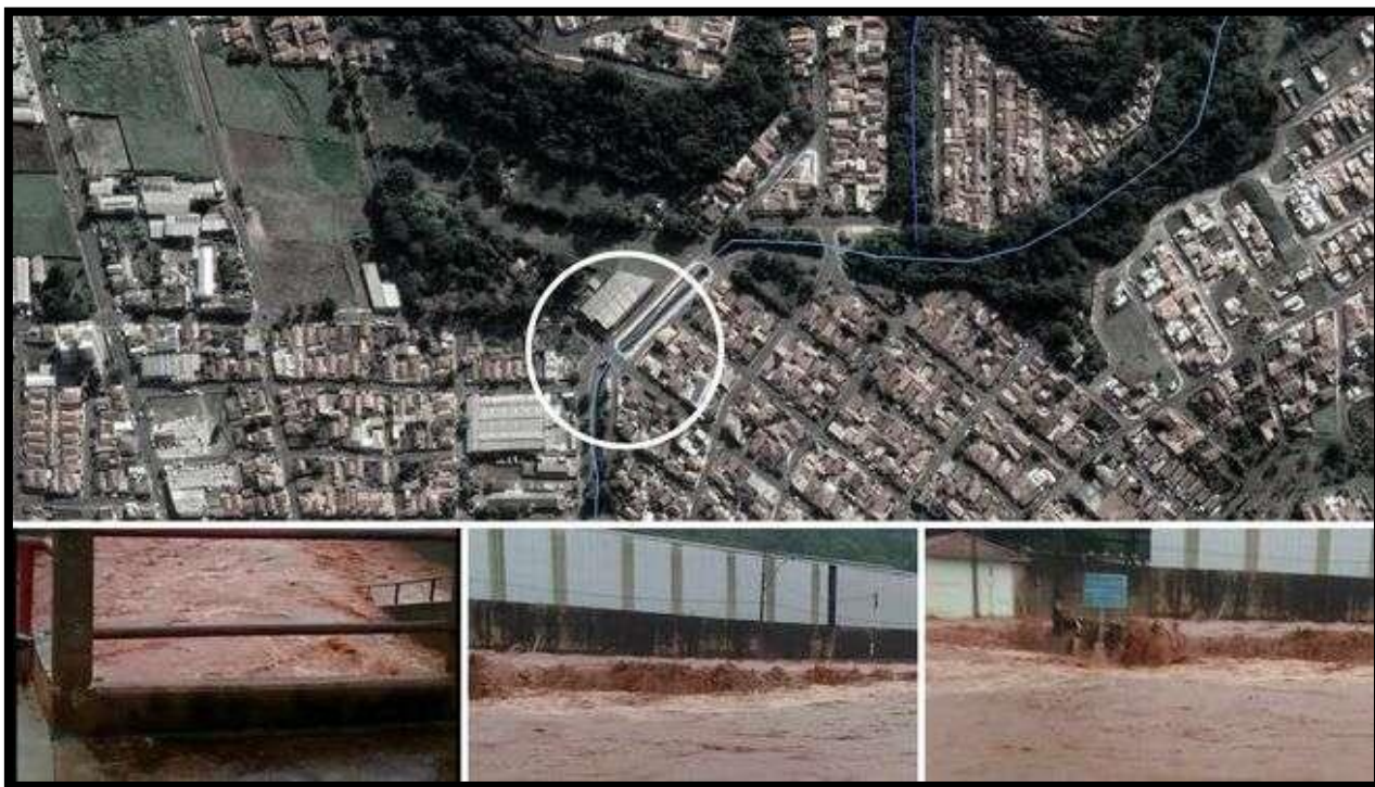
Figura 20 - Área problemática 02 do Córrego Barra Bonita
