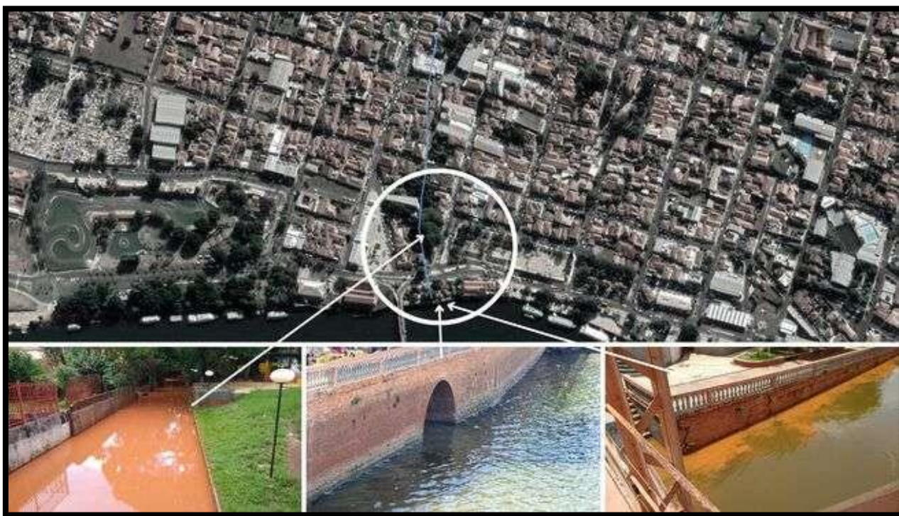
Figura 19 - Área problemática 01 do Córrego Barra Bonita
