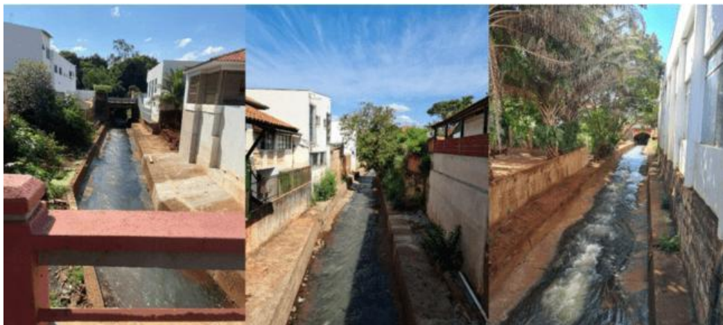
Figura 16 - Canalização e retificação do Córrego Barra Bonita
