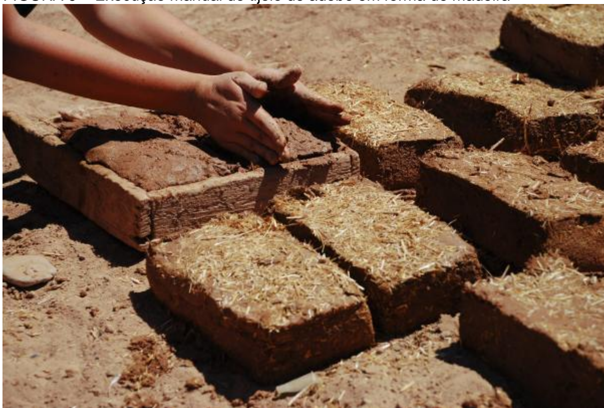
FIGURA 9 – Execução manual do tijolo de adobe em forma de madeira
