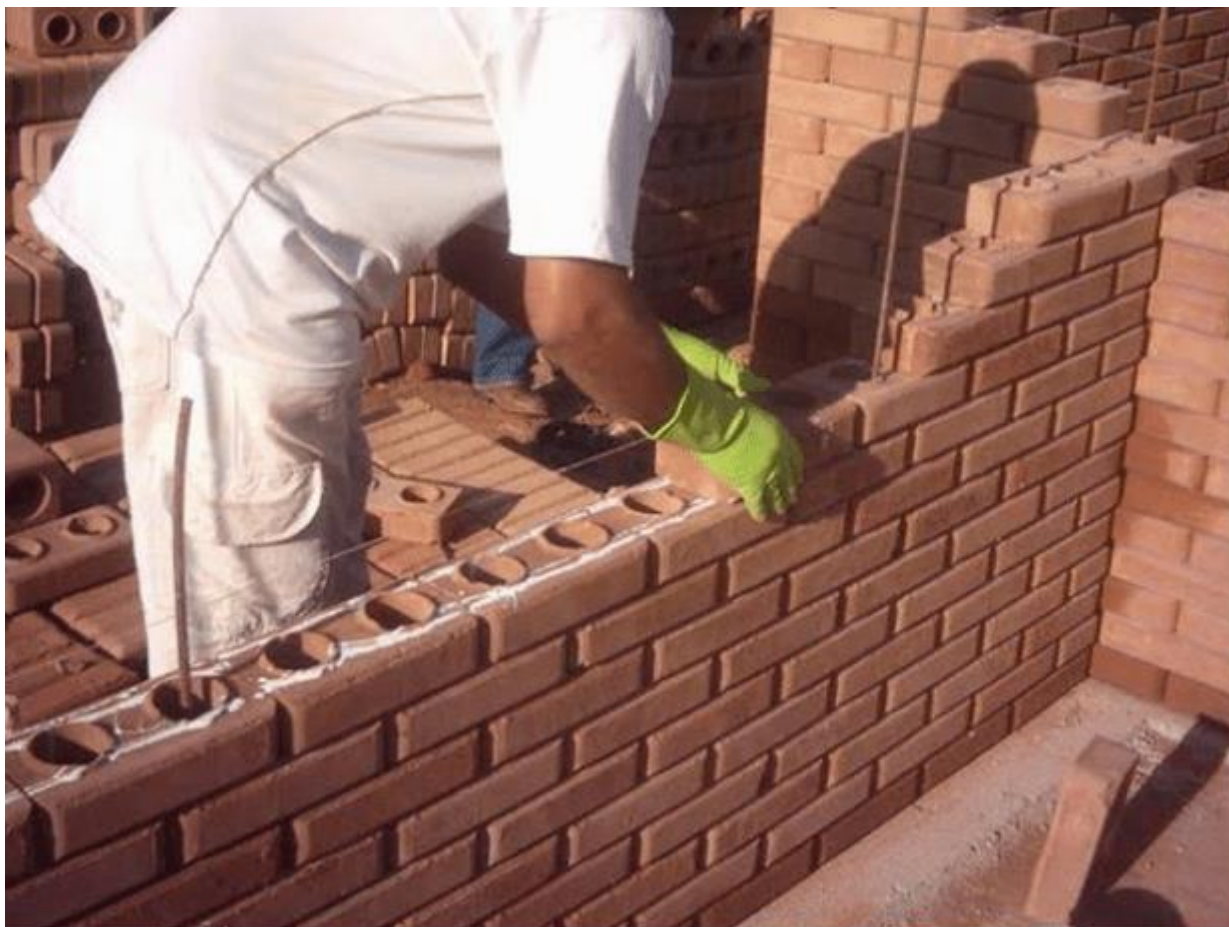
FIGURA 6 – Execução da alvenaria com tijolo de solo cimento
