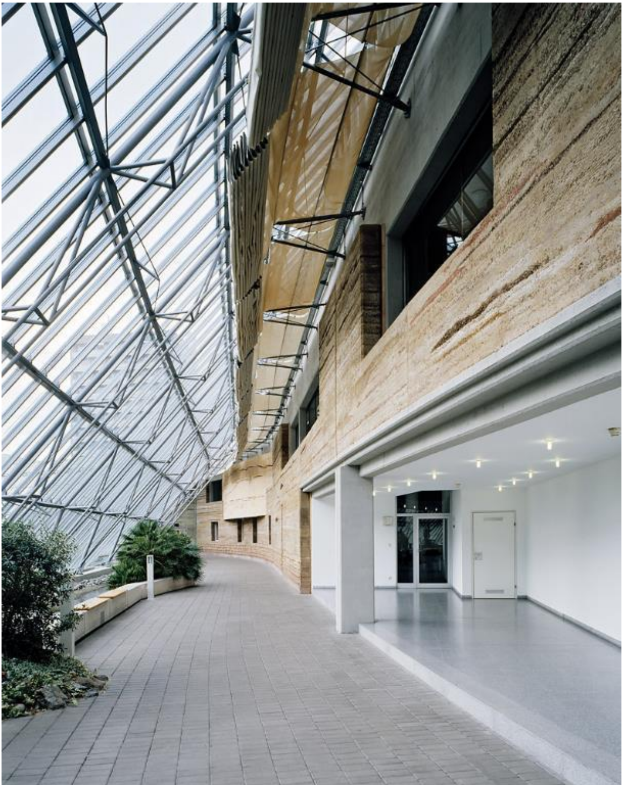
FIGURA 18 – Corredor principal com parede em taipa
