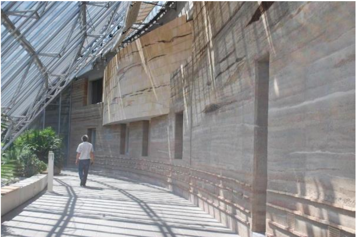
FIGURA 19 – Corredor principal com parede em taipa
