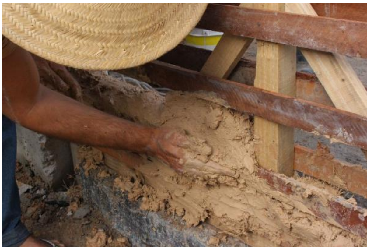
FIGURA 12 – Execução da parede de taipa de mão
