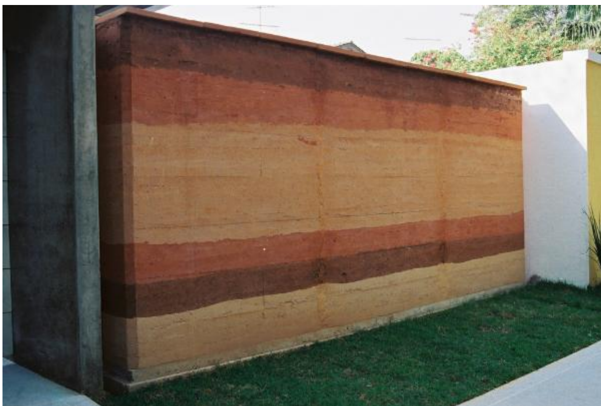
FIGURA 15 – Demonstração das camadas da taipa de pilão
