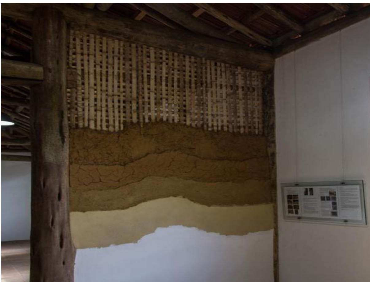
FIGURA 11: Representação de uma parede de taipa de mão
