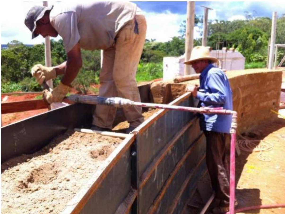
FIGURA 14 – Execução da parede de taipa de pilão manualmente
