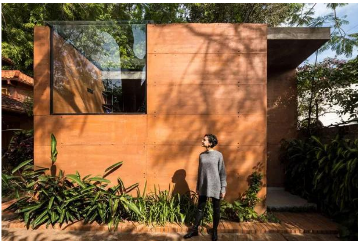
FIGURA 46 – Fachada do escritório
