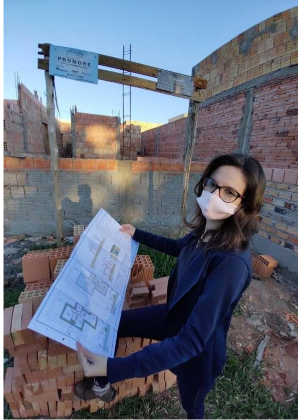
Figura 25: Arquiteta Juliana Piffanelli em obra beneficiada pelo PROMORE (2020)
