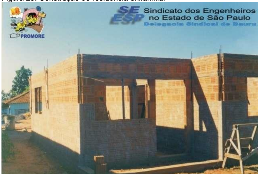
Figura 29: Construção de residência unifamiliar
