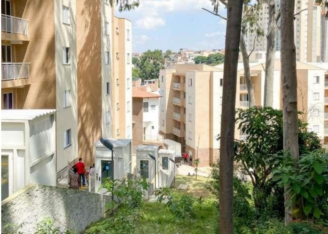
Figura 15: Vista 01 do condomínio Barra do Jacaré
