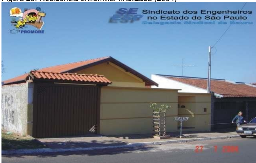
Figura 28: Residência unifamiliar finalizada (2004)
