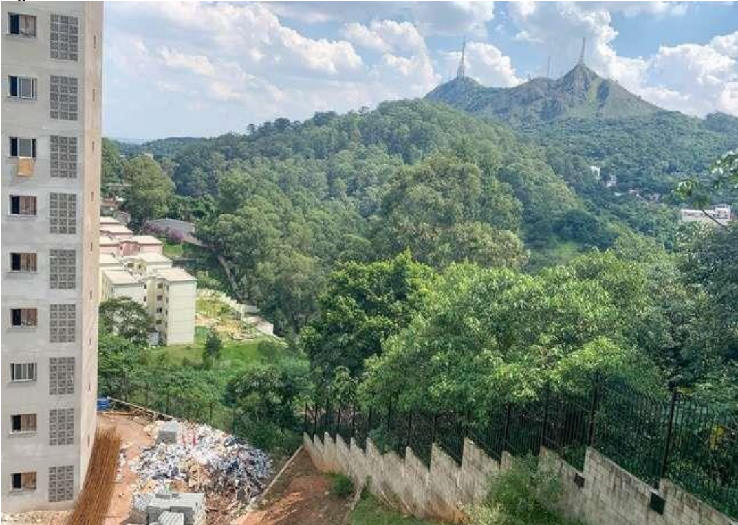
Figura 19: Vista 02 do condomínio Barra do Jacaré
