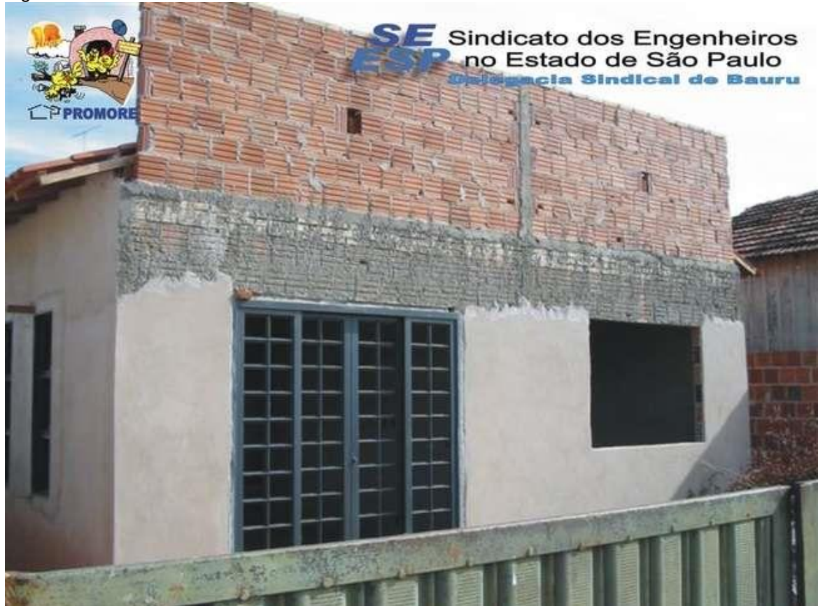
Figura 33: Fase de acabamento de residência unifamiliar
