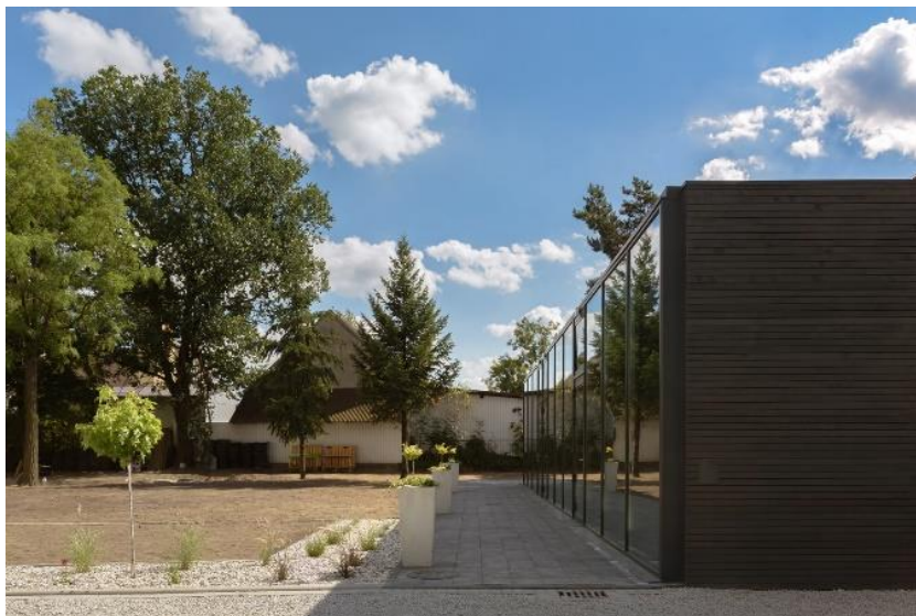
Figura 23. Jardim de Infância em Opole - Exterior
