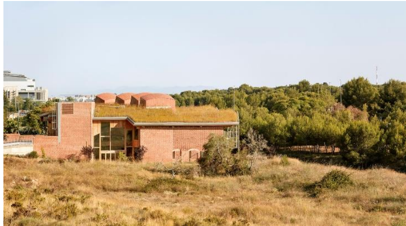
Figura 17. Escola Imagine Montessori - Telhado Verde
