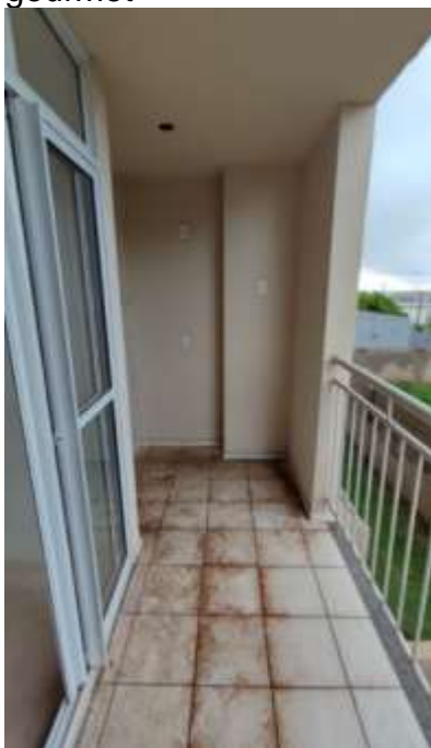
Figura 22: Vista da varanda gourmet
