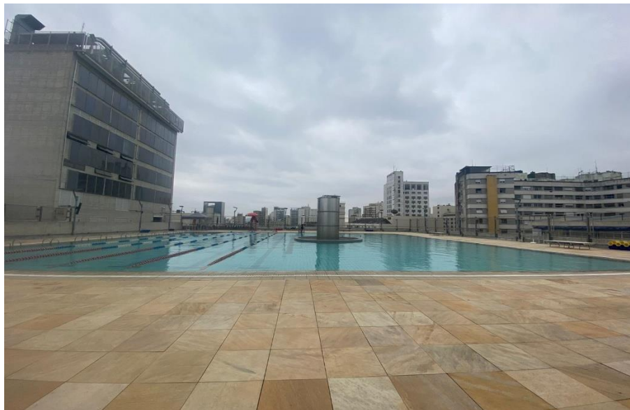
Figura 61 - Piscina descoberta na cobertura do prédio
