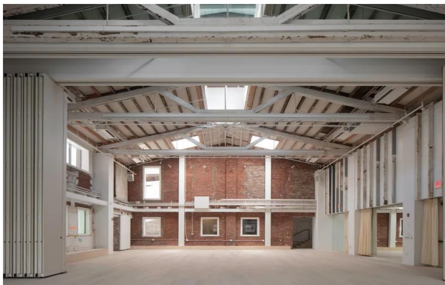
Figura 46 - Preservação dos tijolos e das treliças
