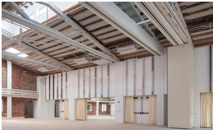
Figura 42 - Estrutura interna do edifício
