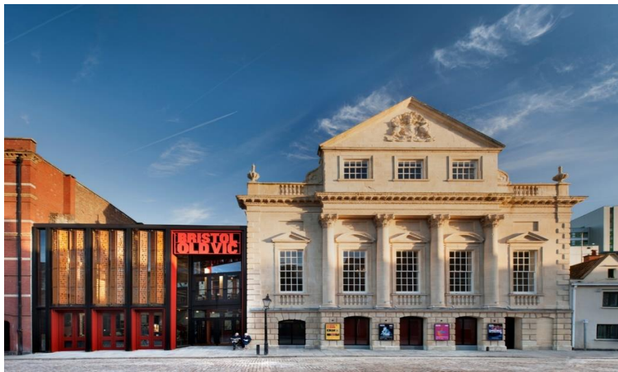
Figura 33 - Fachada atual do Bristol Old Vic
