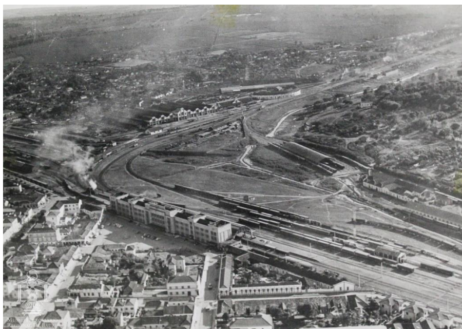
Figura 85 - Esplanada do Pátio Ferroviário em 1950
