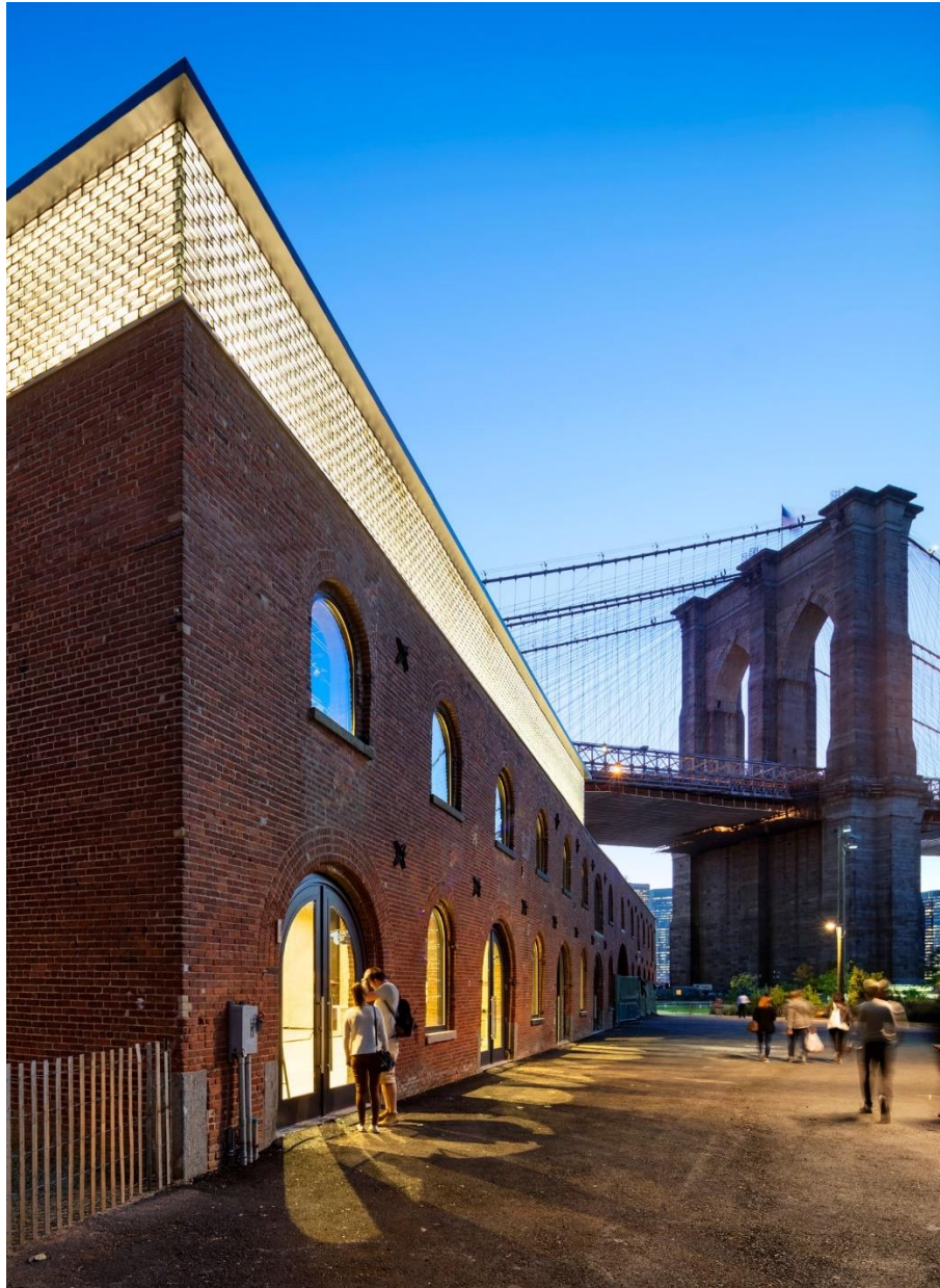
Figura 28 - Volume de tijolos de vidro que se ilumina a noite
