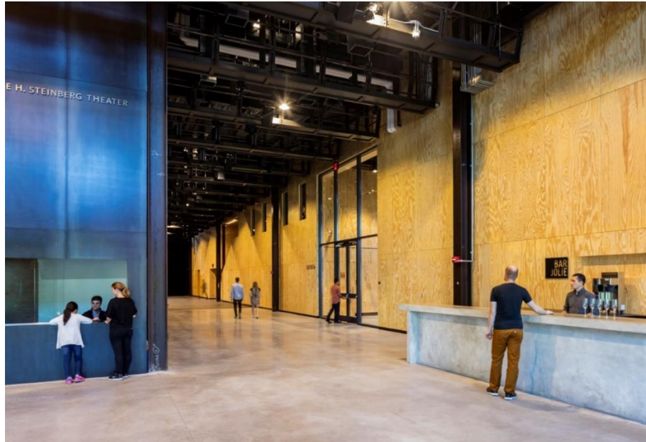
Figura 27 - Revestimento em madeira compensada nas paredes
