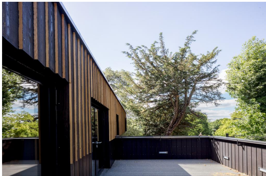
Figura 38 - Materialidade da edificação
