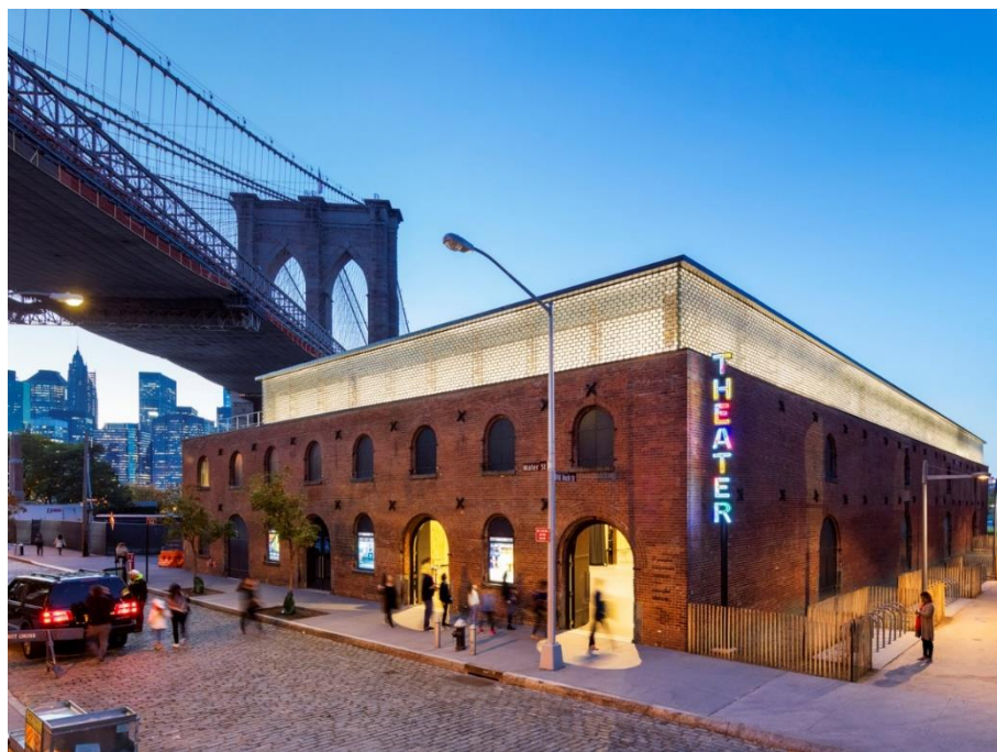
Figura 21 - Fachada atual do St. Ann's Warehouse
