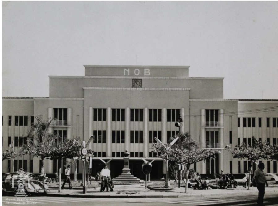
Figura 4 - Estação Central de Bauru tombada em 1999
