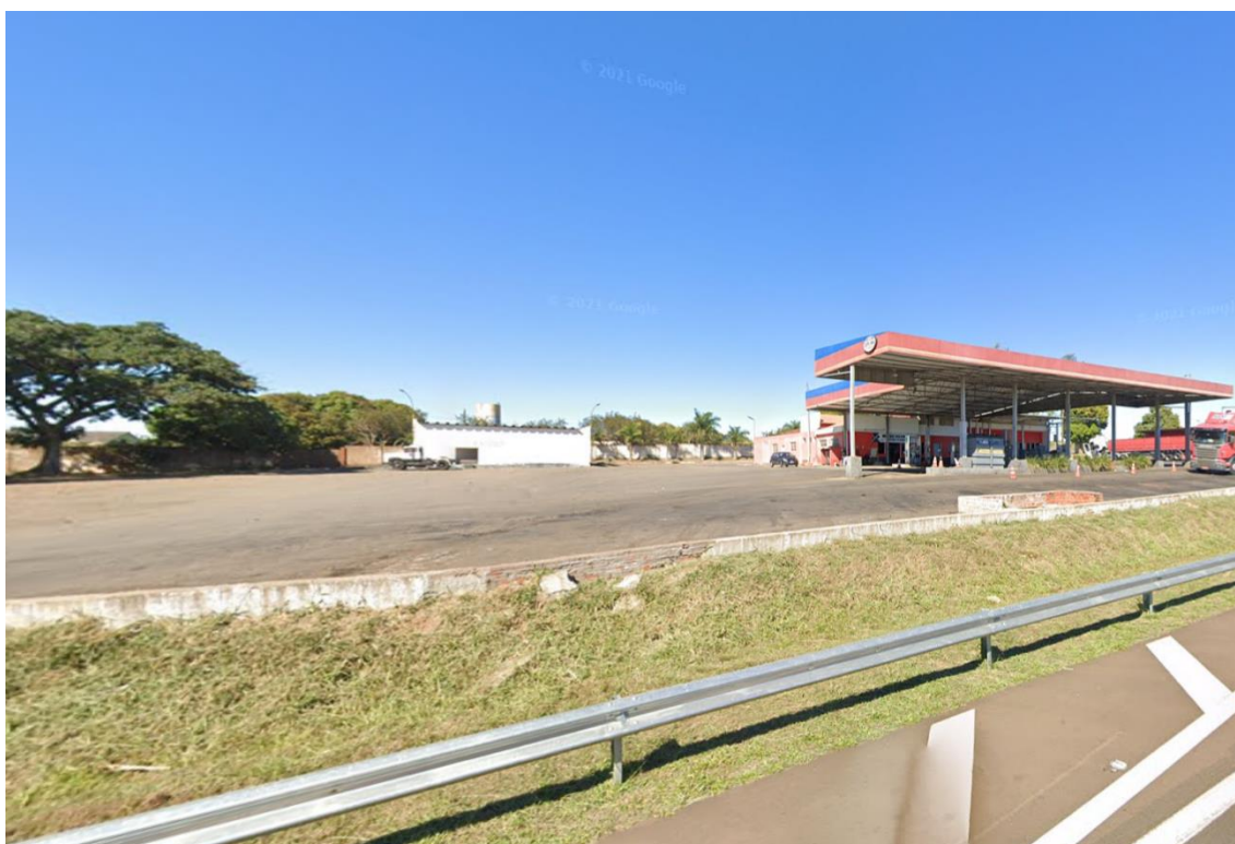
Figura 43: Imagem do Posto Rodoviário Capelinha, Guarapuã – SP.
