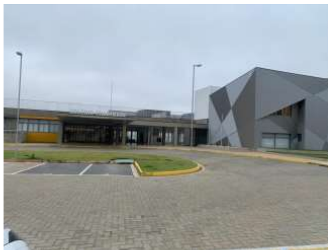
Figura 43: Fachada principal do colégio
