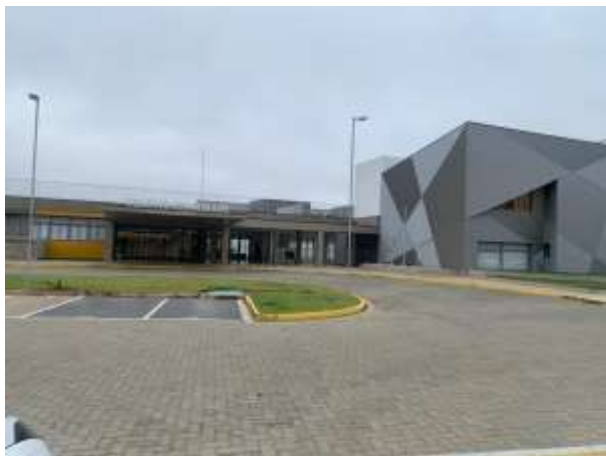
Figura 56: Fachada principal do colégio
