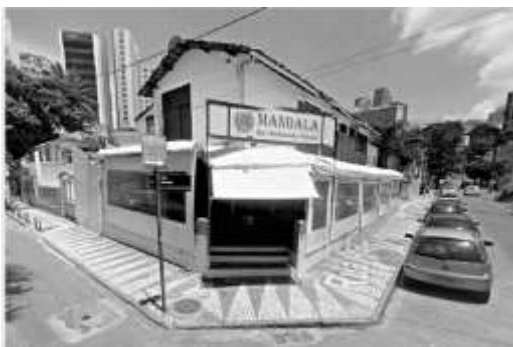
Figura 22. Fachada da casa em seu estado inicial.
