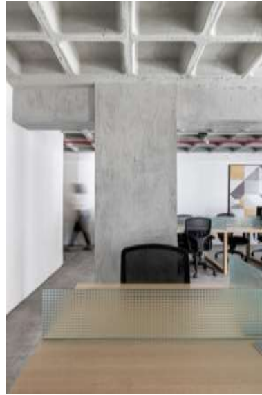
Figura 16. Detalhe da laje nervurada.
