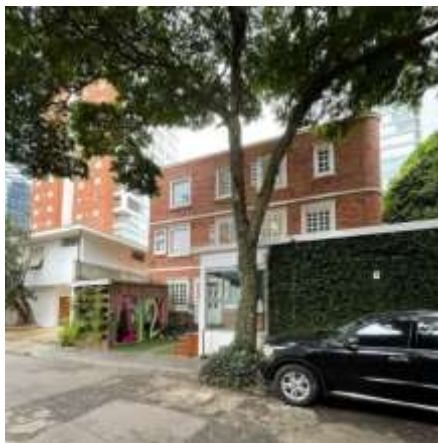
Figura 77. Fachada de uma das casas
