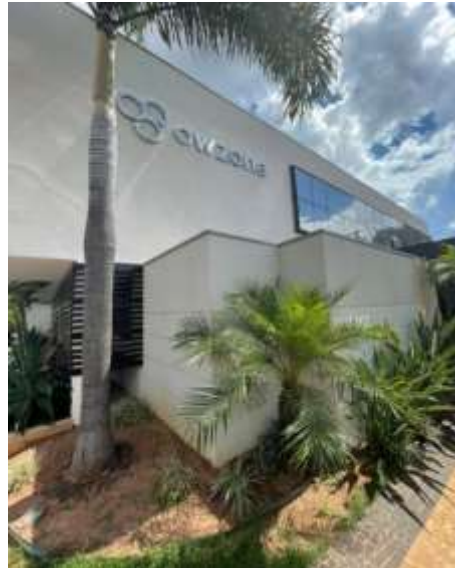
Figura 68. Lateral do Edifício.
