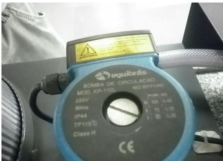
Figura 14 - Bomba de circulação utilizada no experimento modelo KP-110L.
