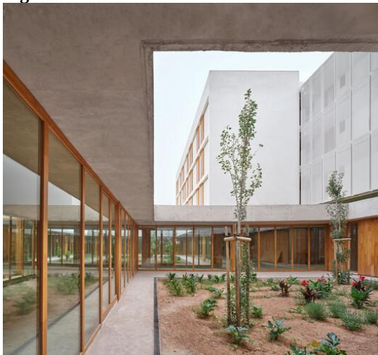
Figura 8 – Vista do Centro Comunitário e Instalações Sociais nos Pisos Superiores
