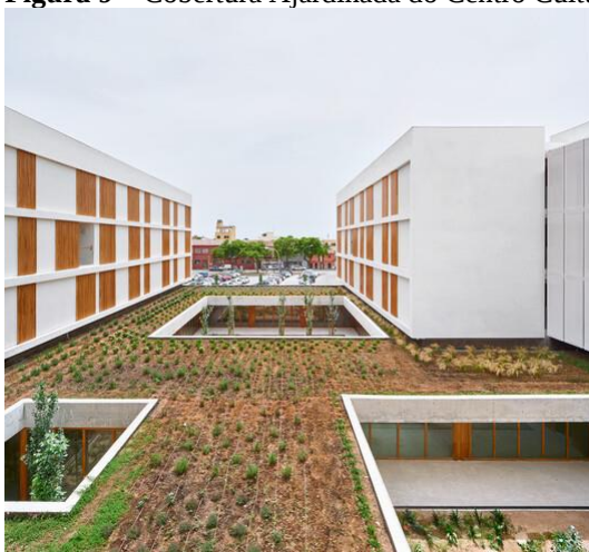
Figura 9 – Cobertura Ajardinada do Centro Cultural
