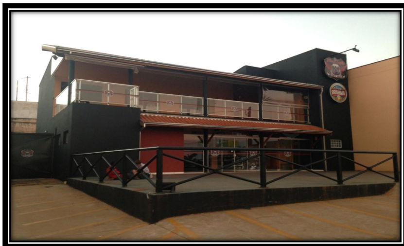
Figura 39- Fachada Black Eagle Rock Bar. Fonte: Elaborado pelo Autor (2013).
