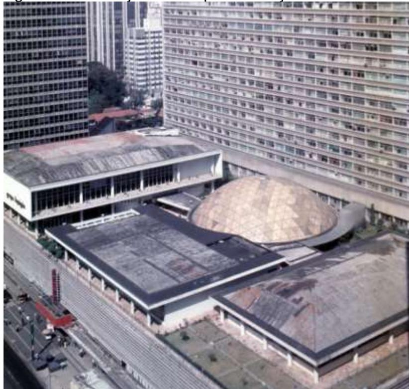
A lâmina vertical compreende um edifício de 121 metros de largura e 19 metros de profundidade, com 25 pavimentos que totalizam 70,75 metros de altura, iniciando
