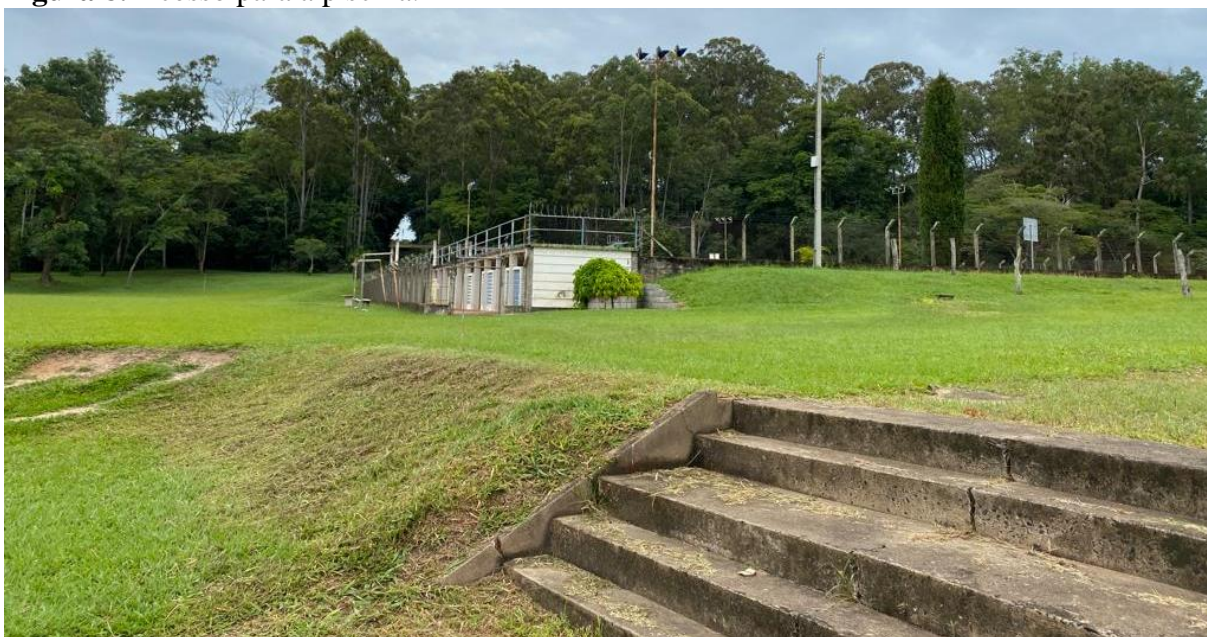
Figura 8. Acesso para a piscina.
