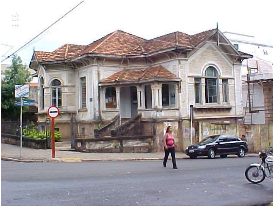
Figura 7 - Edifício da antiga FAC.
