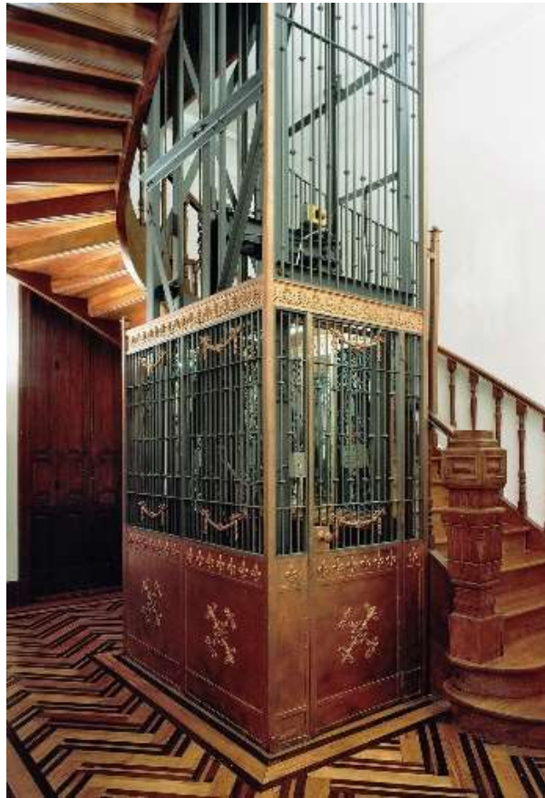
Figura 21 - Vista interna da circulação vertical.
