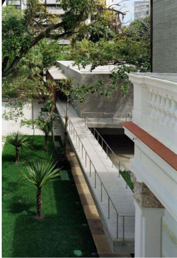
Figura 15 - Passarela de ligação.
