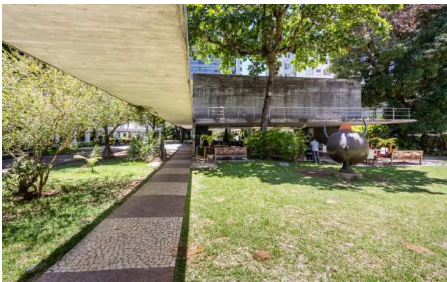
Figura 16 - Passarela na vista do pedestre.
