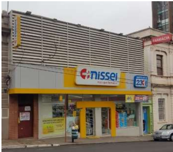
Figura 6 - Edifício da farmácia.
