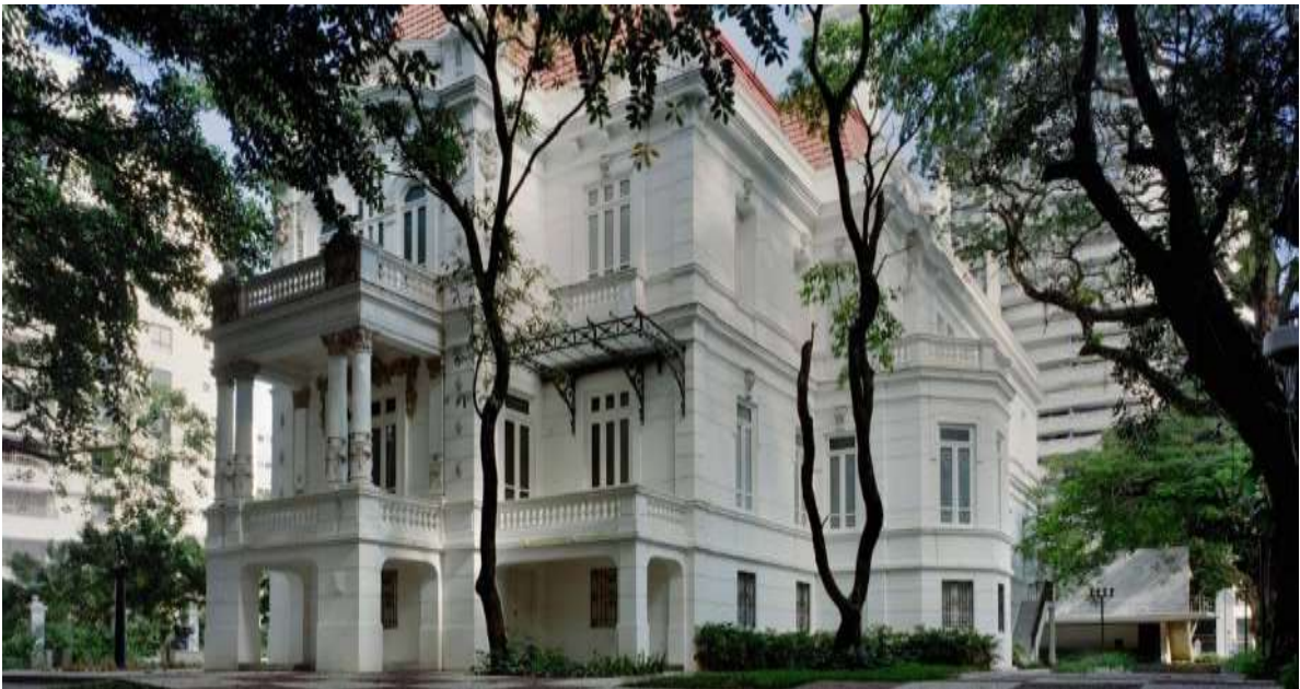
Figura 11 - Fachada do Palacete.
