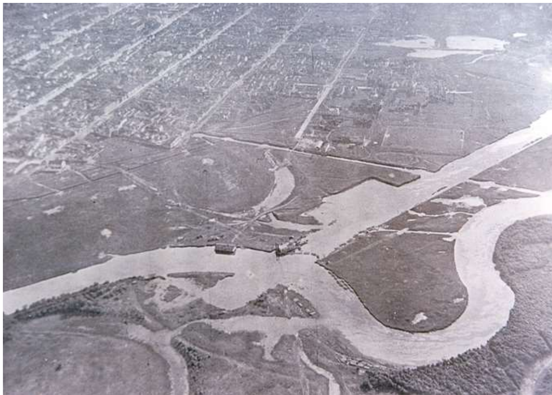
Figura 42: Início da retificação do rio Tietê.
