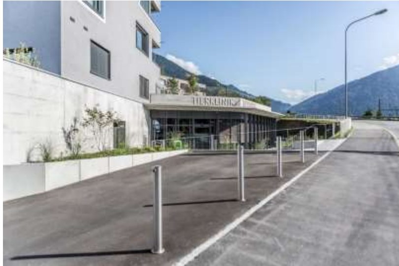
Figura 18: Clínica Veterinária Masans - fachada
