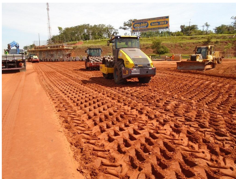
Figura 08 – Compactação de solo como rolo vibratório
