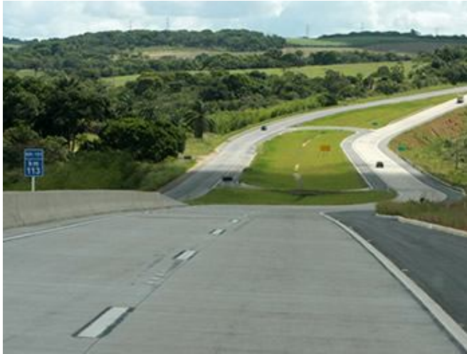
Figura 06 – Pavimento de concreto
