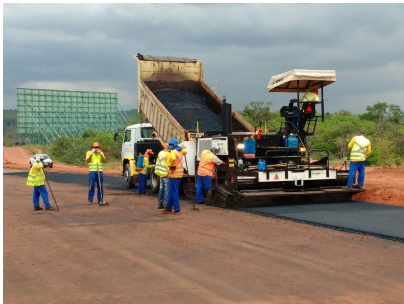
Figura 09 – Pavimentação de via
