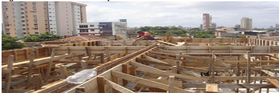
Figura 13 - Formas construção civil
