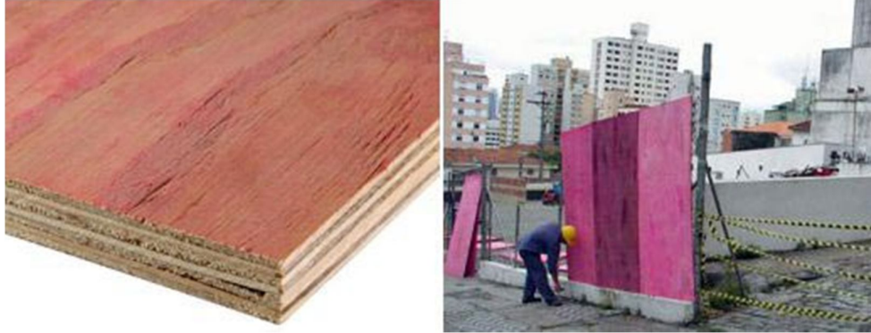
Figura 15 - Tapume compensado resinado
