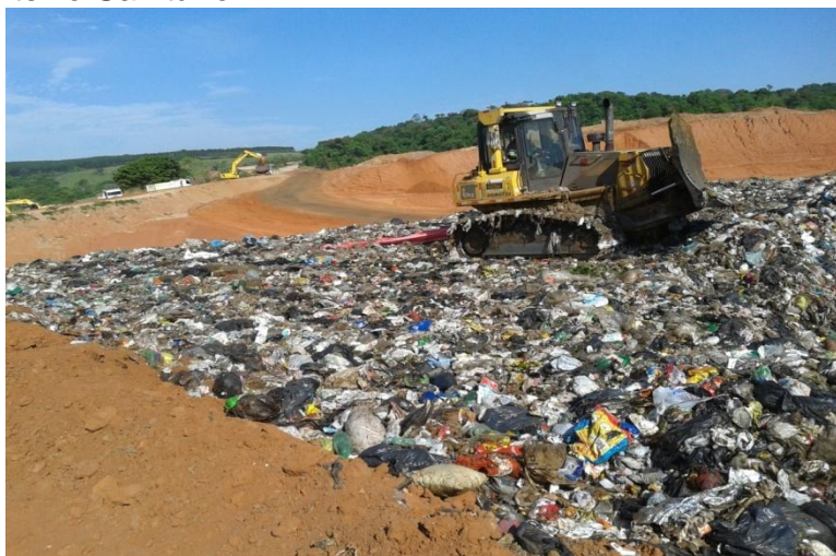
Figura 15 - Compactação dos resíduos dispostos no Aterro Sanitário.
