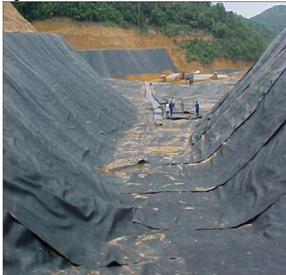
Figura 19 - Manta de PEAD sobre o solo.
