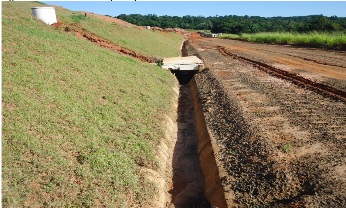
Figura 29 - Canaletas de proteção de bermas e taludes.
