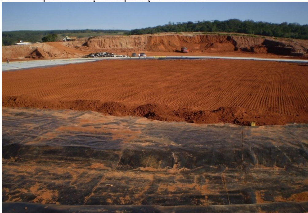
Figura 22 - Camada de terra compactada aplicada sobre a Manta de PEAD para execução da proteção mecânica.
