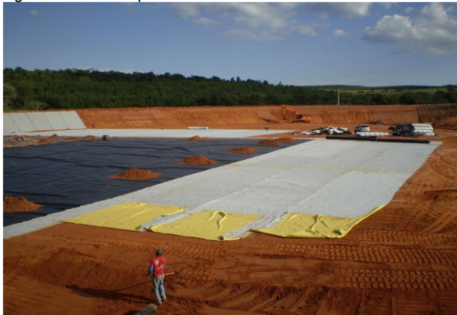
Figura 17 - Instalação da Geomembrana GCL (Geocomposto - à direita) e instalação da Geomembrana de PEAD (Polietileno de Alta Densidade – à esquerda) sobre o solo regularizado e compactado.
