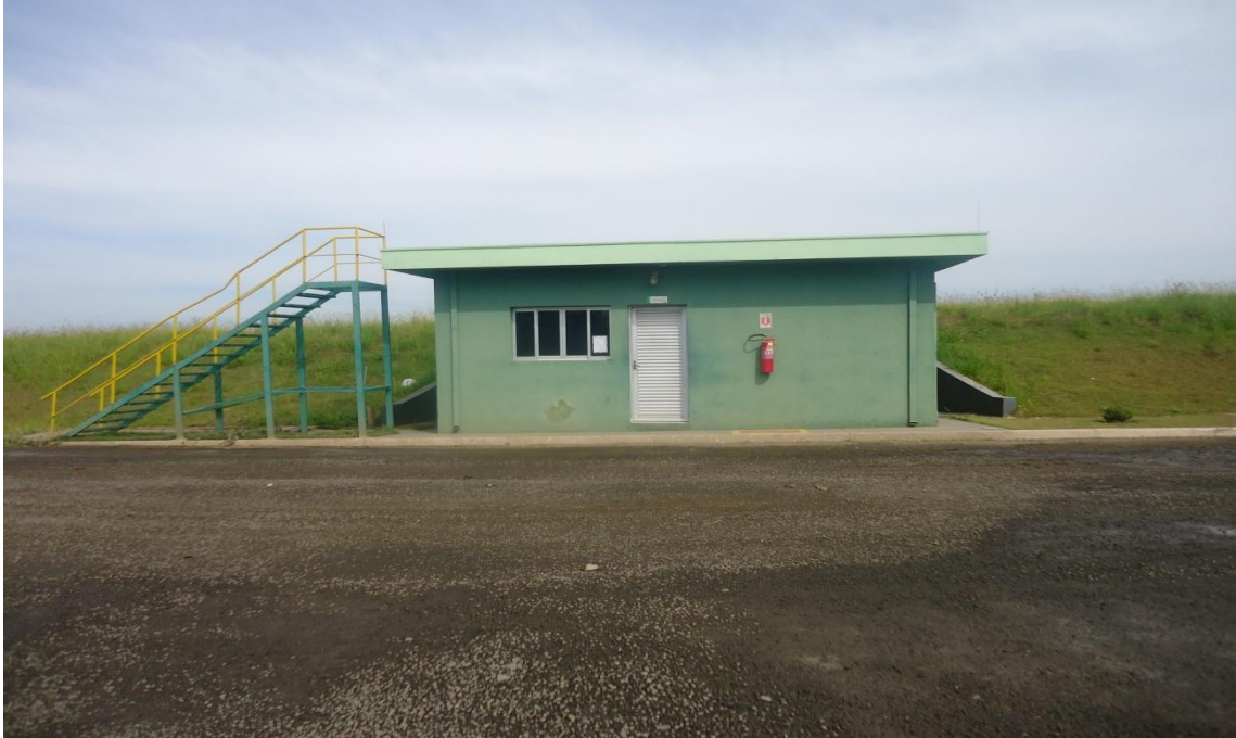
Figura 6 - Laboratório para análises físico-químicas de resíduos industriais.
