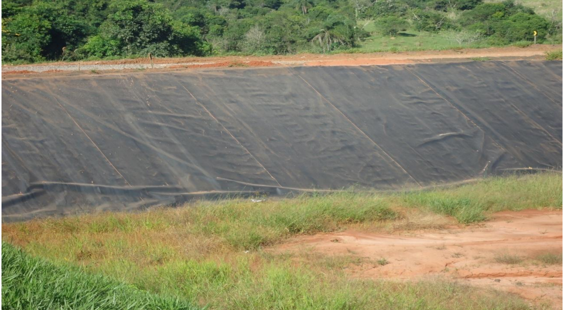
Figura 20 - Manta impermeabilizante fixada no talude lateral do Aterro Sanitário.
