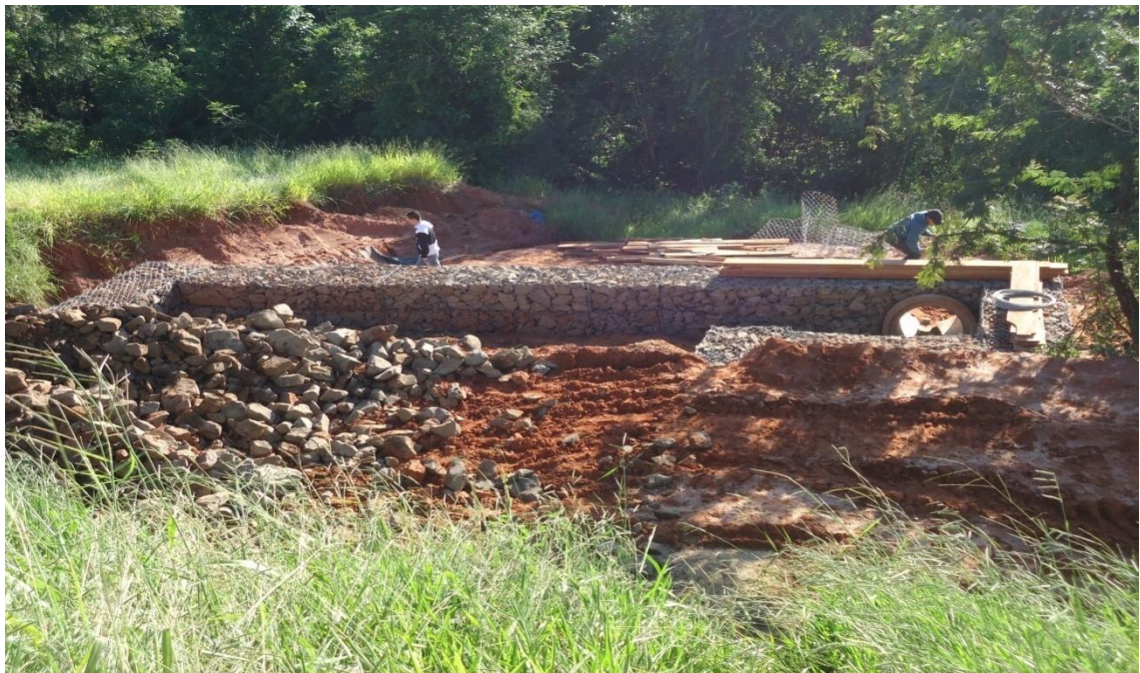
Figura 31 - Estrutura de Gabião localizada no final do dispositivo de descida.
