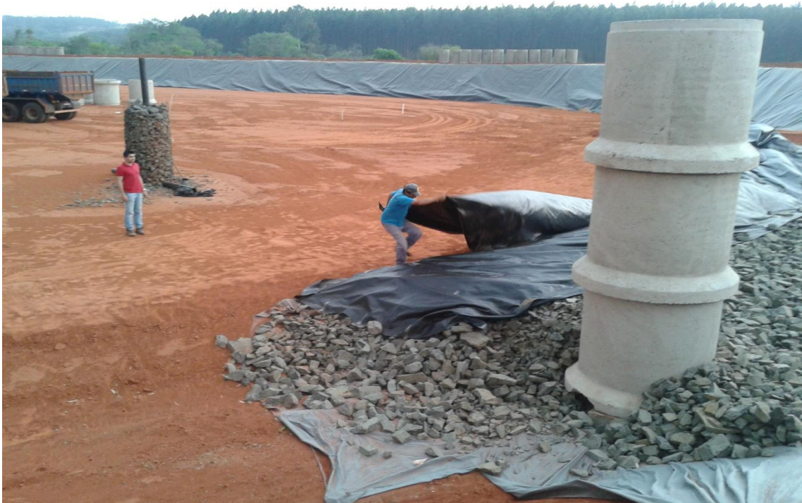
Figura 26 - Execução do dreno tipo “Colchão Drenante” sobre a base impermeabilizada.
