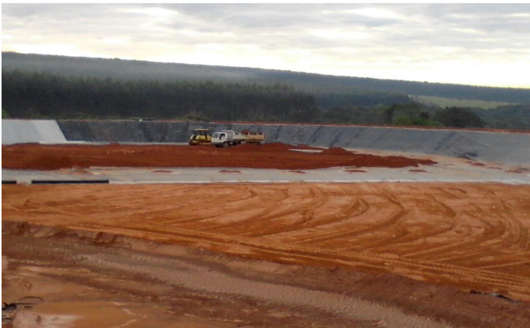
Figura 21 - Aplicação da proteção mecânica para a Manta de PEAD.
