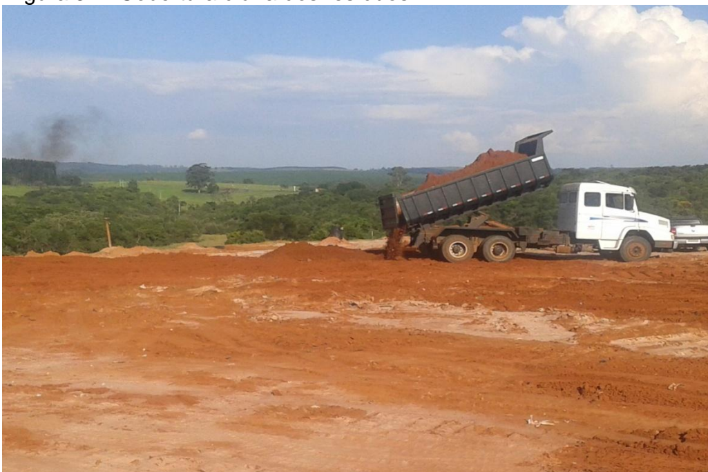
Figura 32 - Cobertura diária dos resíduos.
