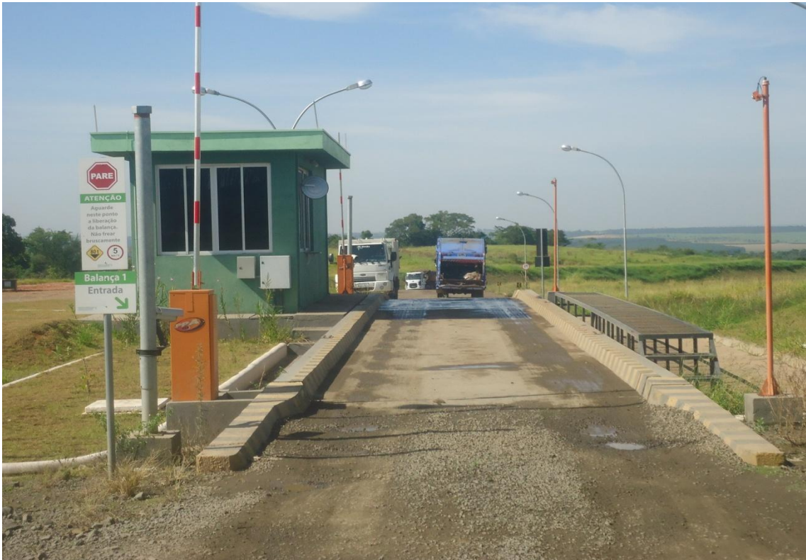
Figura 3 - Balança rodoviária instalada na entrada do Aterro para pesagem de caminhões.
