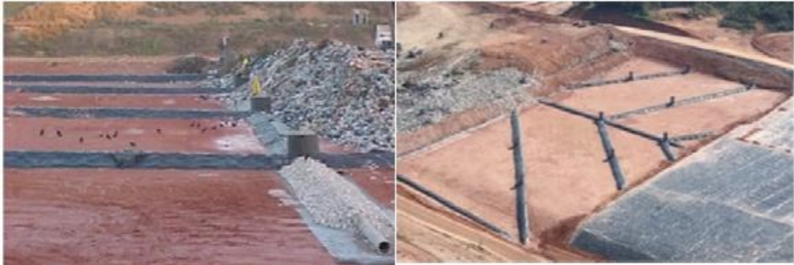
Figura 24 - Sistema de Drenagem de Líquidos Percolados e Gases sobre impermeabilização de fundo.
