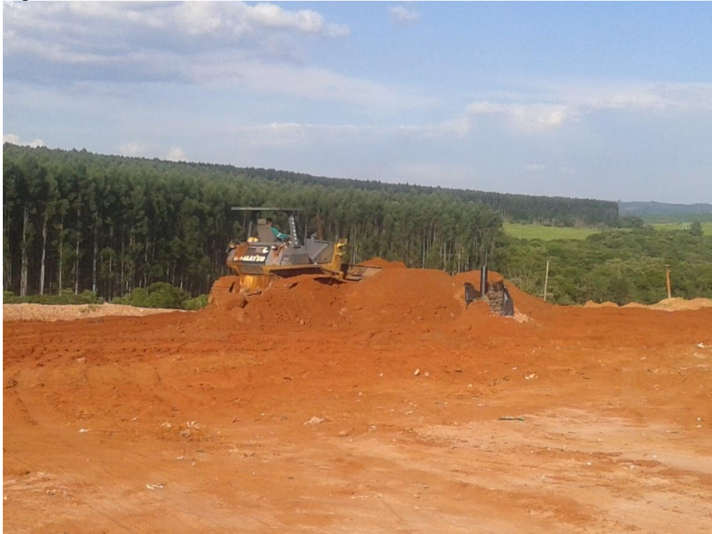
Figura 33 - Cobertura diária dos resíduos.
