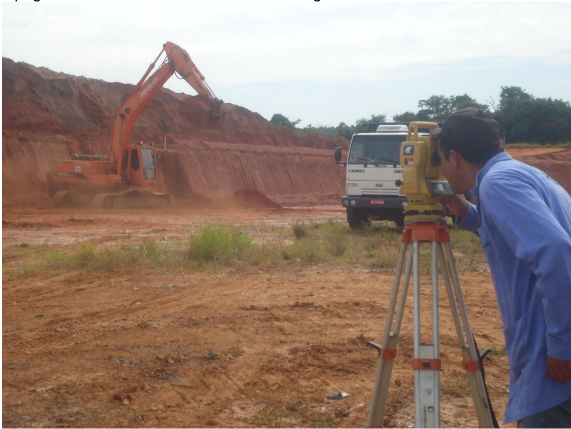
Figura 35 - Monitoramento geotécnico executado pela equipe de topografia no Aterro Sanitário CGR Piratininga.
