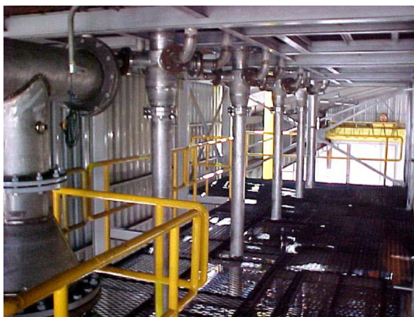
Figura 2 - Bicos ejetores de gás. Fonte: Engenho Novo Tecnologia ([2012])
