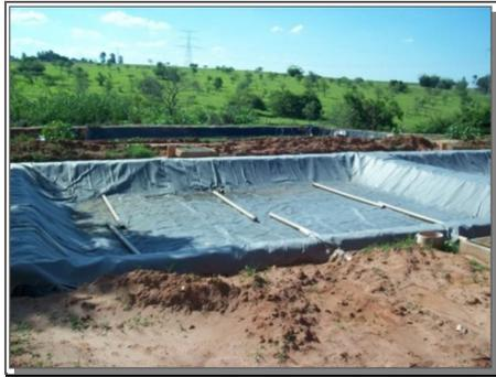
**Figura 17.** Leitões dos alagados construídos da ETE Tibiriçá.
