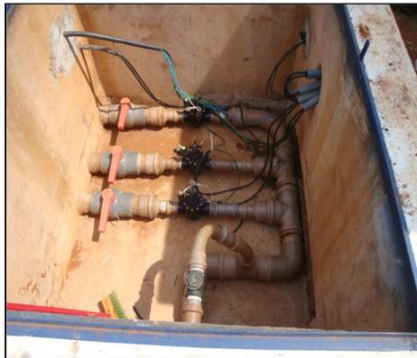
**Figura 20.** Foto da caixa com as eletroválvulas programadas para enviar o efluente intercaladamente aos alagados construídos.
