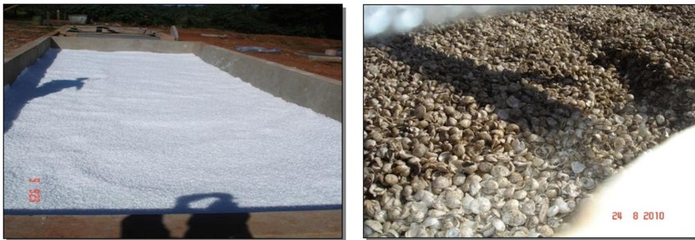
**Figura 16.** Vista do filtro anaeróbio de fluxo ascendente com o meio suporte em EPS com forma geométrica côncava, antes e durante a operação.
