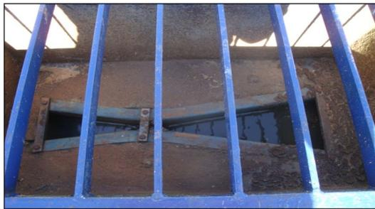
**Figura 15.** Foto da Calha Parshall da ETE Tibiriçá.
