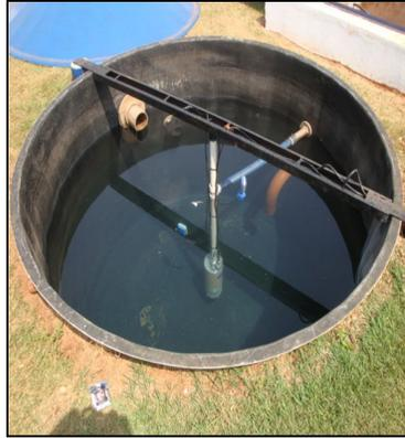
**Figura 19.** Foto da caixa de passagem do efluente do filtro anaeróbio para os alagados construídos.
