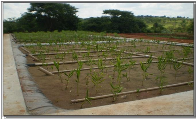
**Figura 18.** Vista dos alagados construídos com as tubulações drenantes superficiais e cultivo com macrófitas emergentes.
