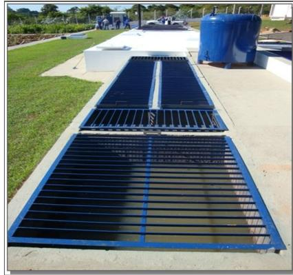
**Figura 14.** Foto da caixa de desarenação do esgoto da ETE Tibiriçá.
