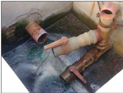
**Figura 24.** Caixa com drenos em dois níveis.
