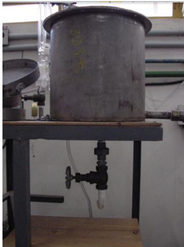
Figura 11: Válvula para a retirada do vapor condensado Fonte: Tavares (2007)
