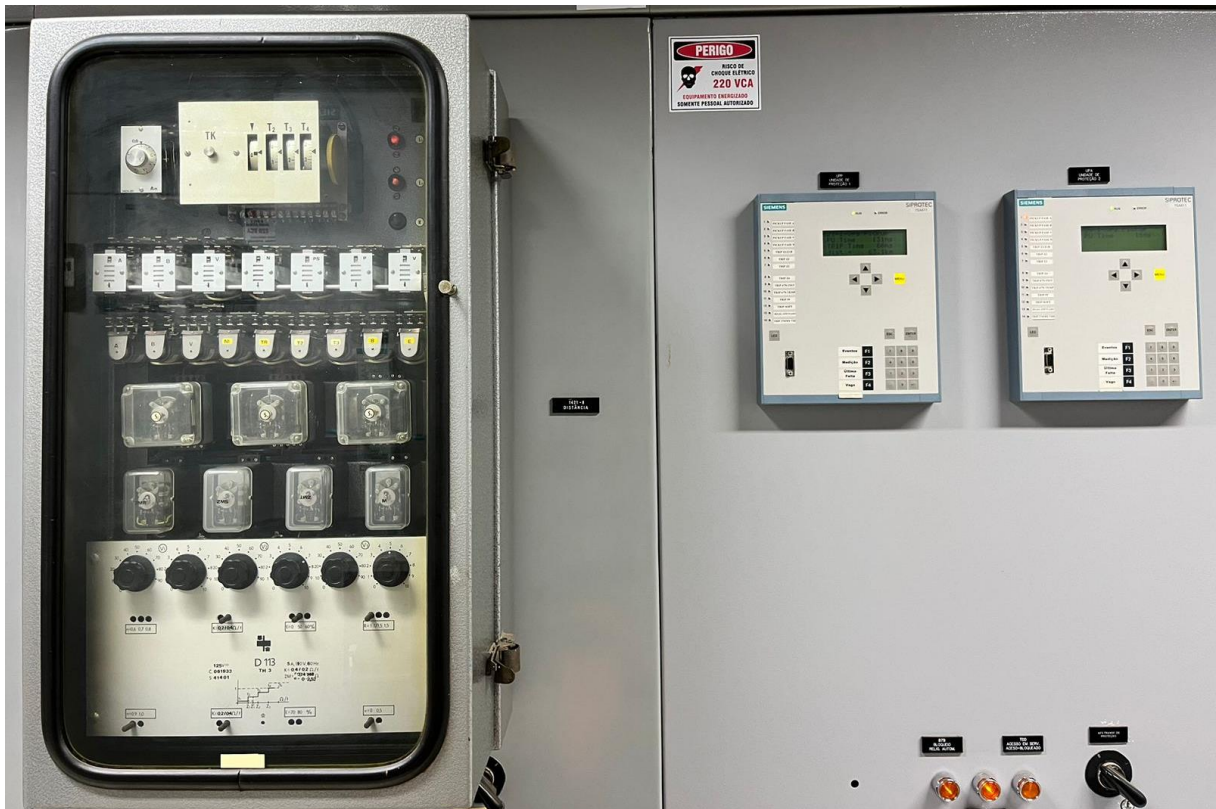
Figura 6. Comparação de IEDs eletromecânico e digital.
