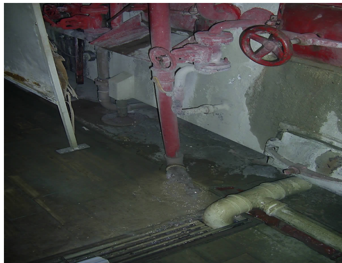
Figura 4: Efluente gerado na lavadora de garrafas Fonte: elaborado pela autora
