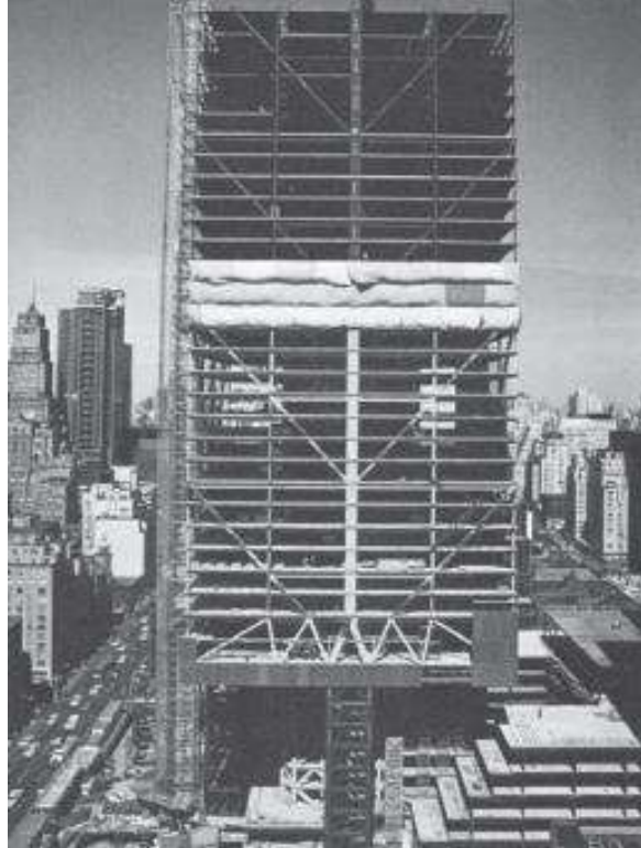
Figura 19 – Estrutura do Edifício Citicorp Center
