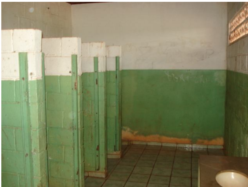
Figura 23 - Banheiro público da Prainha Fonte: Arquivo pessoal
