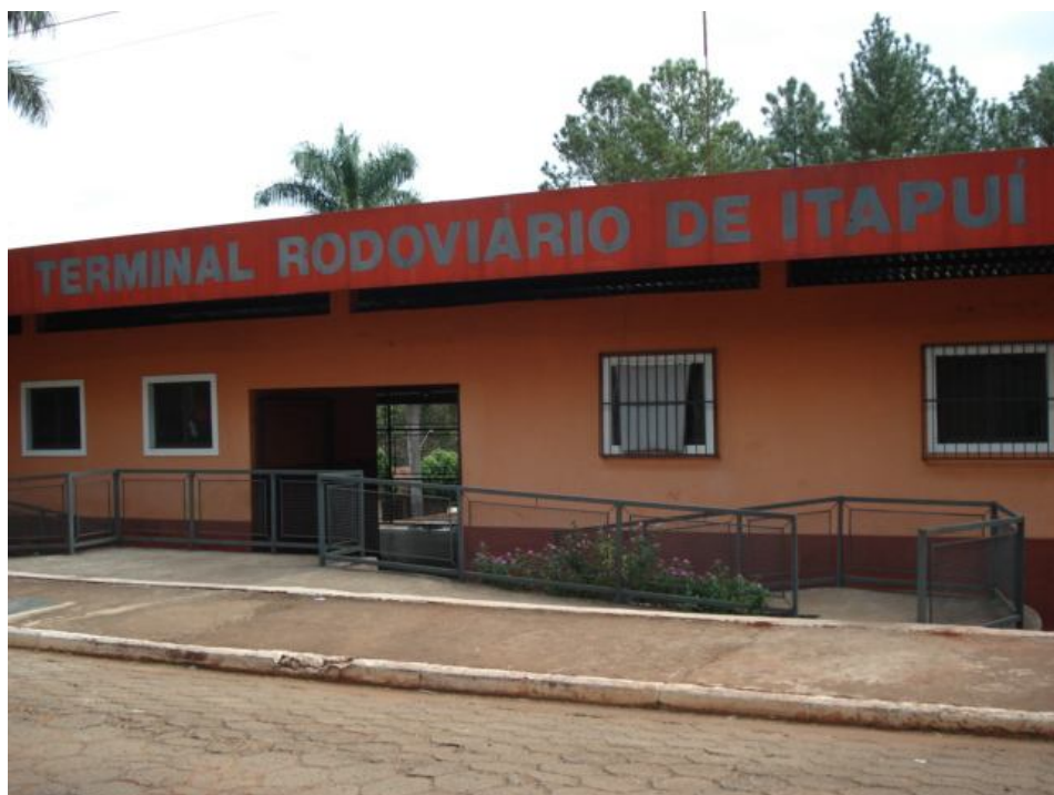
Figura 40 - Terminal Rodoviário de Itapuí Fonte: Arquivo pessoal
