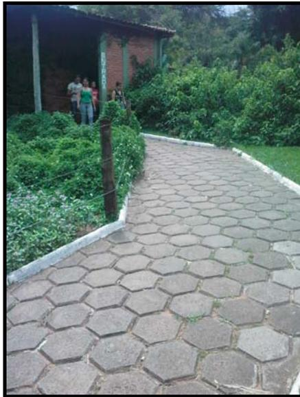
Figura 36 – Vista de uma rampa com pavimento de concreto hexagonal.
