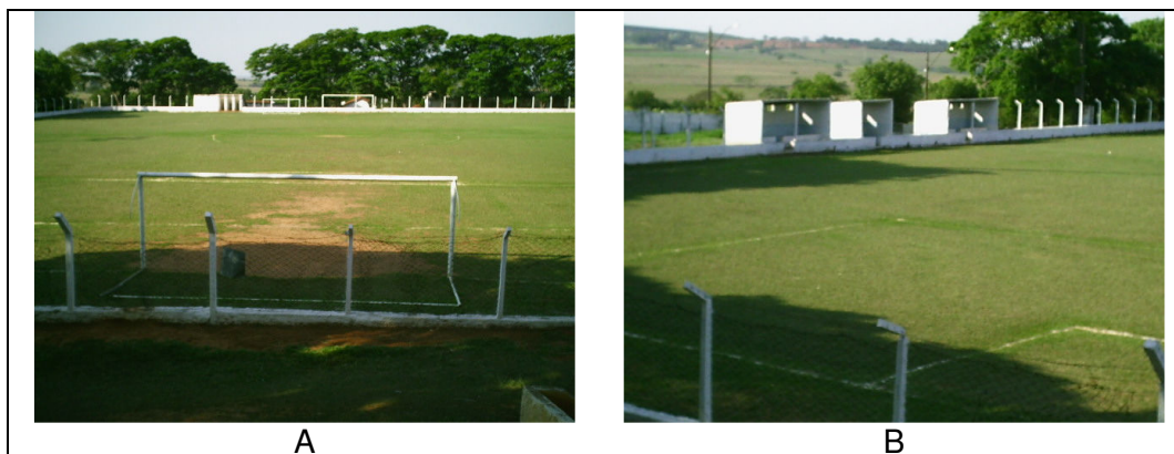
Figura 5 – Dependências do Campo de Futebol Municipal: (A) Vista frontal do campo; (B) Vista lateral do campo Fonte: Acervo pessoal
