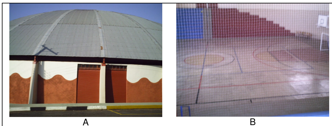
Figura 4 – Ginásio de Esportes: (A) Fachada do ginásio; (B) Vista do interior do ginásio
