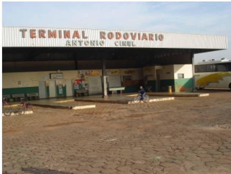
Figura 55 – Vista do Terminal Rodoviário de Reginópolis (SP) Fonte: Reginópolis (2008)
