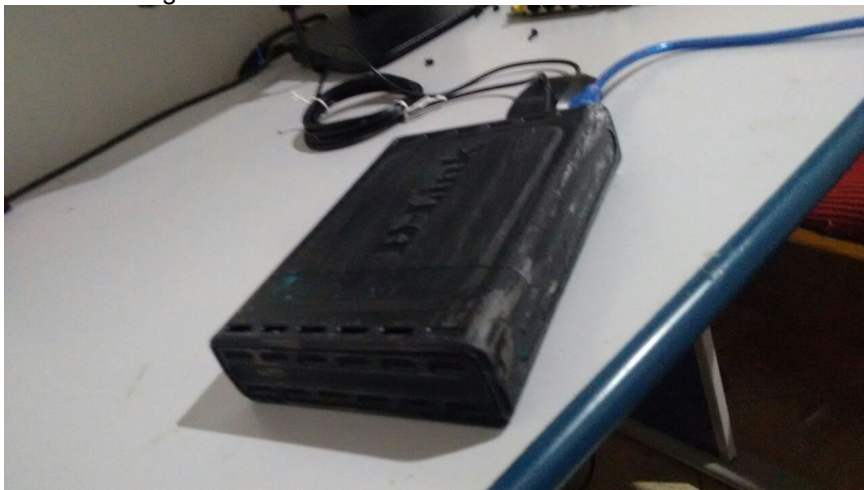
Figura 34 – Caixa do Roteador Fechada e Pintada
