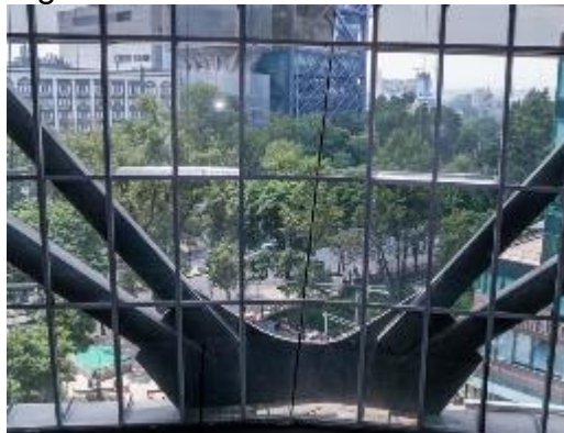
Figura 18: Torre Reforma - interior
