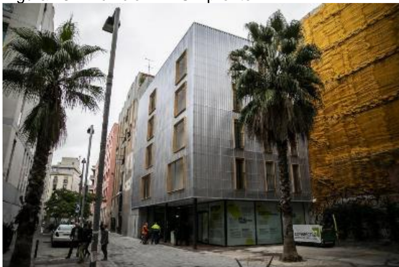
Figura 437: Edifício APROP pronto
