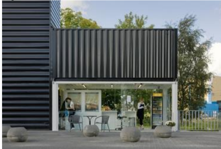
Figura 404: Acesso ao Barneveld Noord Station.
