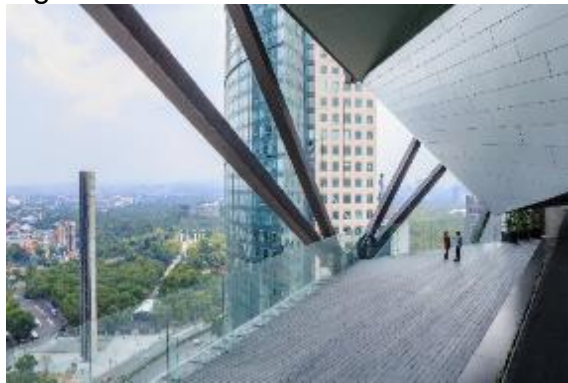
Figura 17: Torre Reforma - interior
