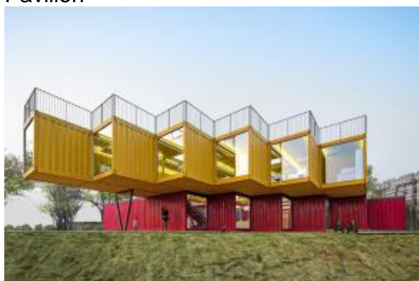
Figura 31: Vista externa Contênier Stack Pavilion
