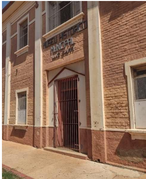
Figura 4 – Acesso posterior ao museu- Desnível de 30cm do solo
